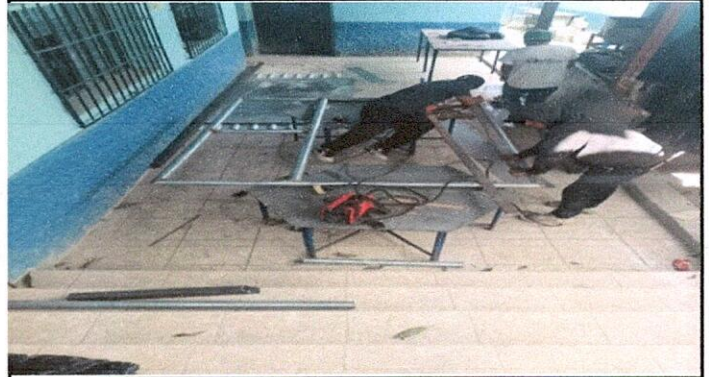
Foto 2: PUERTAS DE METAL 4.5 Sustrucción de portón de metal
