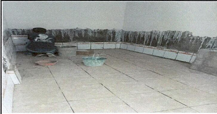
Foto 7: 21 EPARACIÓN Y REPELLO DE CERNIDO Y REPELLO DE PAREDES (CUANDO APLIQUE): 21.2 Cernido en muro.
