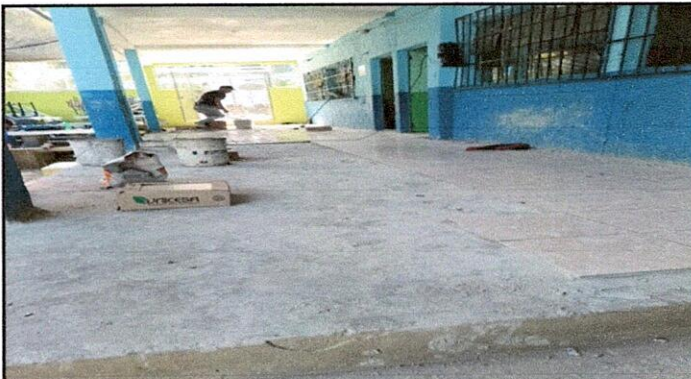
Foto 3: PISO 6.8 Sustrucción de piso cerámico
