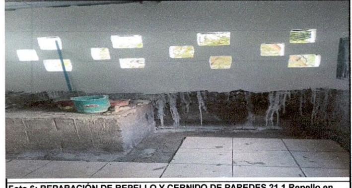
Foto 6: REPARACIÓN DE REPELLO Y CERNIDO DE PAREDES 21.1 Repello en muro 21.2 Cernido en muro
