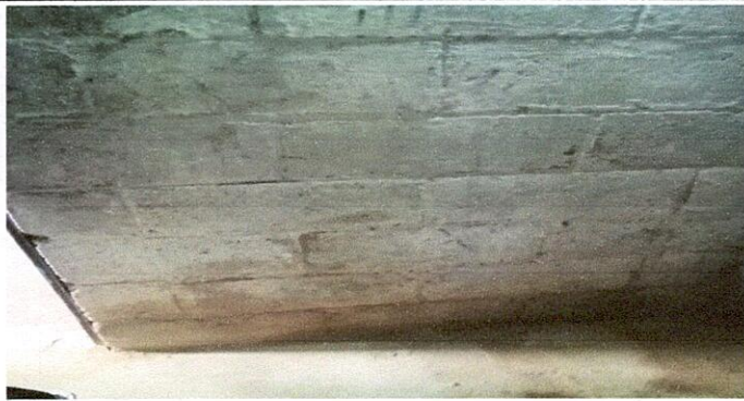
Foto 7: 21 REPARACIÓN DE REPELLO Y CERNIDO DE PAREDES , (CUANDO APLIQUE) : 21.2 Cernido en muro.
