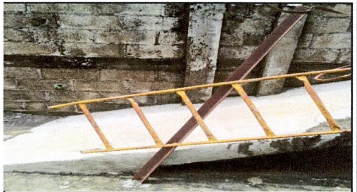
Foto 4: MANTENIMIENTO A BARANDAS 11.2 Sustitución de barandas de metal
