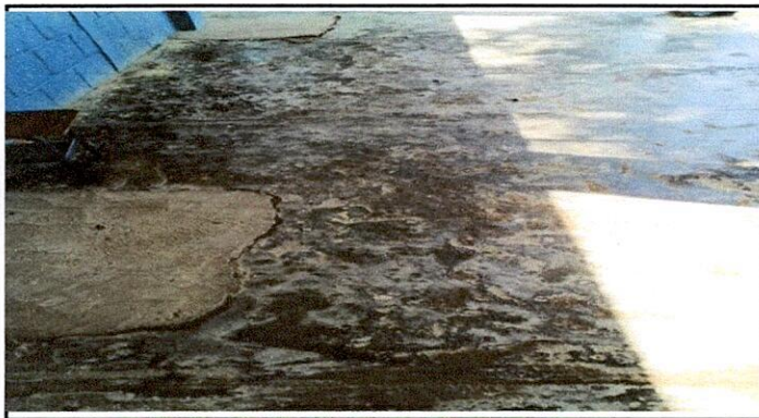
Foto 3: PISO 6.8 Sustitución de piso cerámico
