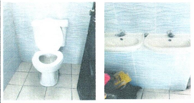
Foto 2: 13 SUSTITUCIÓN DE AZULEJO. 13.1 Sustitución de azulejo
