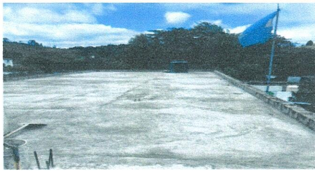
Foto 3: 3. IMPERMEABILIZACIÓN DE LOSA. 3.2 Reparación de pañuelos.
