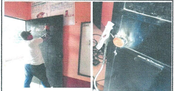
Foto 4: 4.PUERTAS DE METAL. 4.1 Mantenimiento a estructura (pintura) 4.2 Sustitución de chapa.
