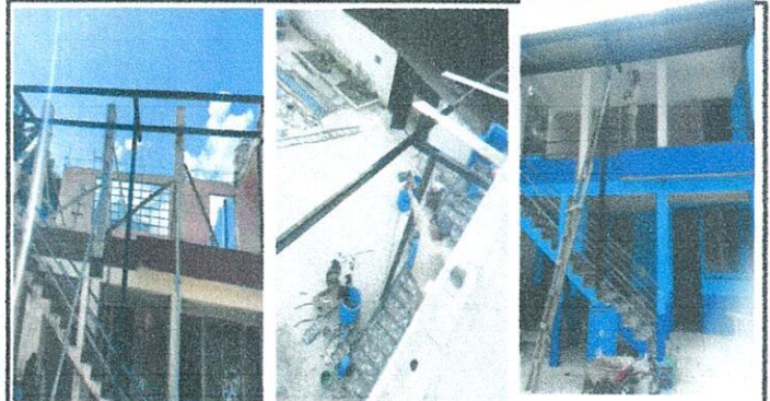
Foto 2: 2. ESTRUCTURA DE TECHO 2.1 Mantenimiento a estructura de soporte de metal.
