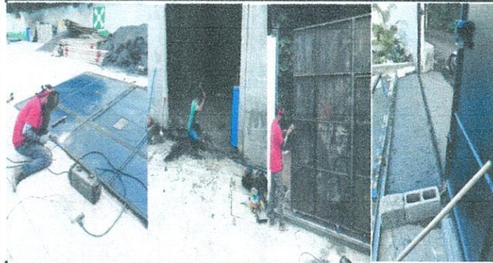
Foto1: 12 MANTENIMIENTO A PORTONES. 12.1 Mantenimiento a portones de metal.
