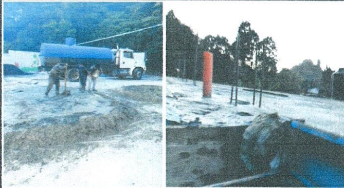
Foto1: LOSA DE AULA DE TERCERO PRIMARIA
