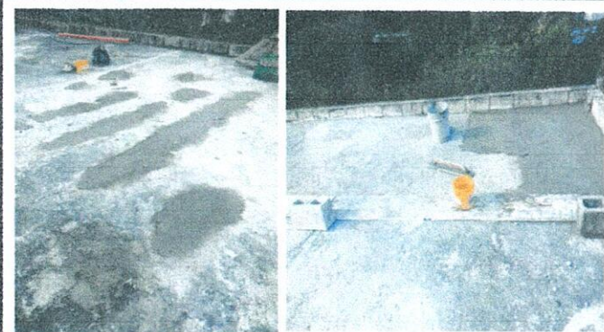
Foto 3: 3.IMPERMEABILIZACIÓN DE LOSA. 3.2 Reparación de pañuelos
