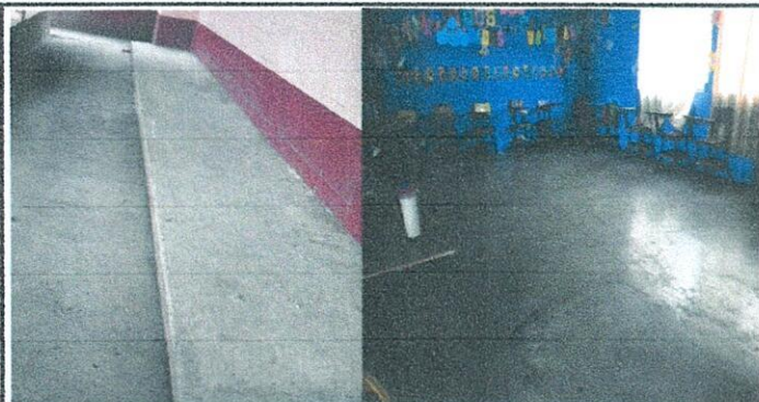
Foto 5: 6.PISO. 6.5 Sustitución de piso de torta de concreto.
