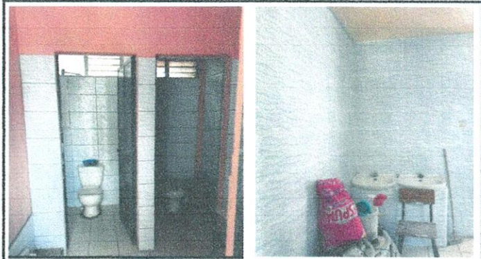
Foto 2: 13 SUSTITUCIÓN DE AZULEJO. 13.1 Sustitución de azulejo
