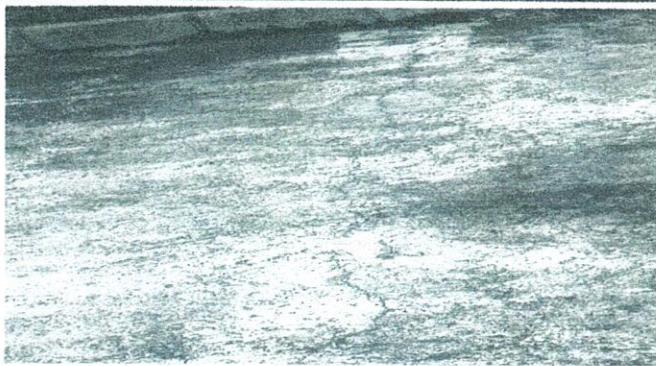
Foto 3: 3. IMPERMEABILIZACIÓN DE LOSA. 3.2 Reparación de pañuelos.
