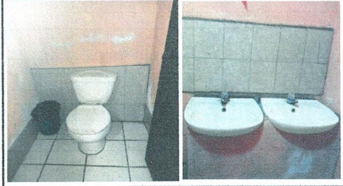
Foto 2: 13 SUSTITUCIÓN DE AZULEJO. 13.1 Sustitución de azulejo
