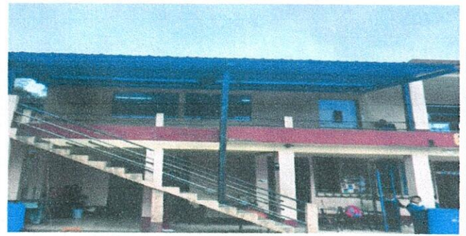
Foto 2: 2 ESTRUCTURA DE TECHO 2.1 Mantenimiento a estructura de soporte de metal.
