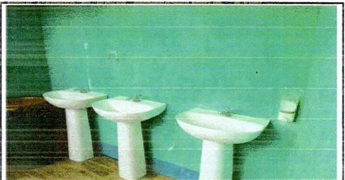
Foto 6: 10 SERVICIO DE SANITARIOS Y SUS ACCESORIOS 10.9 SUSTITUCION DE GRIFOS
