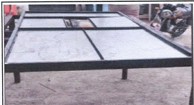
Foto 4: PUERTAS DE METAL 4.1 Mantenimiento a estructura (lijado, cambio de tubo , cepillado, sujeciones, aplicación de pintura)
