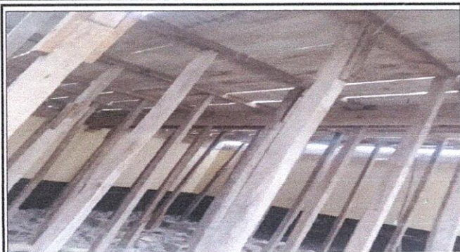
Foto1: CUBIERTA DE LOSA 1.1. Sustitución de cubierta de lámina por cubierta de losa
