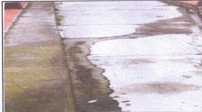
Foto 4: LOSA DE PATIO 16.1 Reparación de parche de concreto de patio
