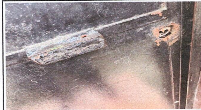
Foto 5: PUERTAS DE METAL 4.2 Sustitución de chapa 4.3 Sustitución de puerta
