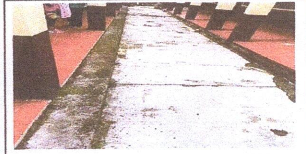
Foto 4: LOSA DE PATIO 16.1 Reparación de parche de concreto de patio
