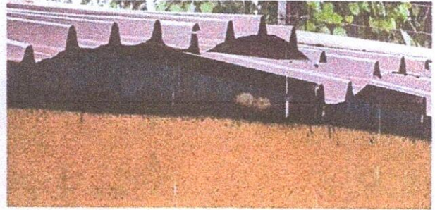
Foto 2: CUBIERTA DE LÁMINA. Sustitución de lámina, por lámina troquelada aluzinc calibre 26
