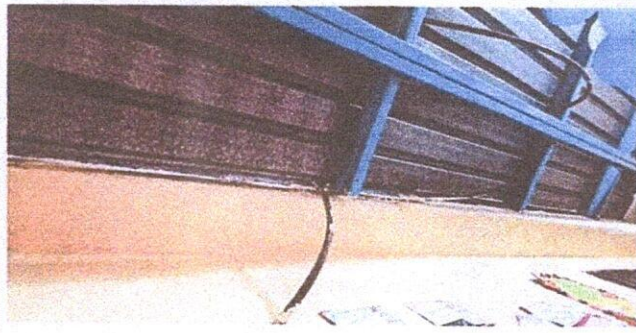
Foto 1: CUBIERTA DE LOSA 1.1. Sustitución de cubierta de lámina por cubierta de losa
