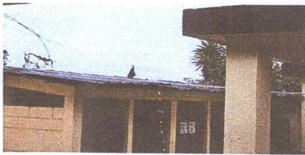
Foto 3: ESTRUCTURA DE TECHO 2.1 Mantenimiento a estructura de soporte de metal
