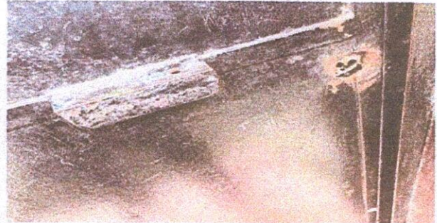
Foto 4: PUERTAS DE METAL 4.1 Mantenimiento a estructura (lijado, cambio de tubo, cepillado, sujeciones, aplicación de pintura)
