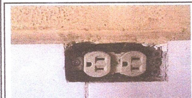
Foto 5: MANO DE OBRA ESPECIALIZADA (ALBAÑILERÍA, HERRERIA, ELECTRICIDAD Y PLOMERÍA) 19.11 Instalación de unidades de luz (interruptor, ducto y cable eléctrico) 19.12 Instalación de unidades de fuerza (tomacorrientes)
