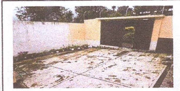
Foto 1: PINTURA EN MUROS EXTERIORES E INTERIORES 9.1 Pintura en muros exteriores e interiores
