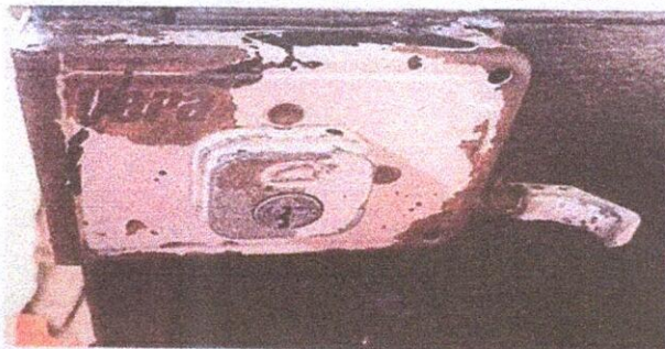
Foto 5: PUERTAS DE METAL 4.2 Sustitución de chapa 4.3 Sustitución de puerta
