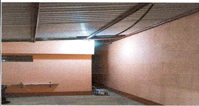
Foto 3: 9.1 Pintura en muros exteriores e interiores
