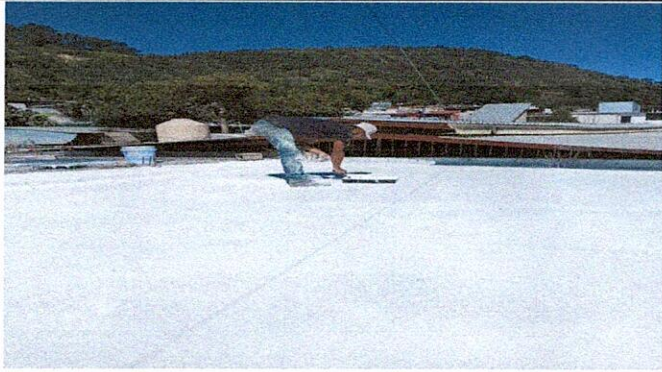
Foto 1: IPERMIABILIZACIÓN DE LOSA 3.1 Ipermiabilización de losa
