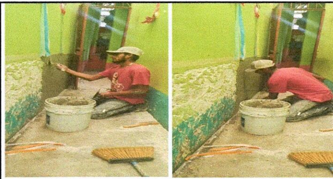
Foto 5: Muros perimetrales 15.1 Reparación de muro perimetral de block
