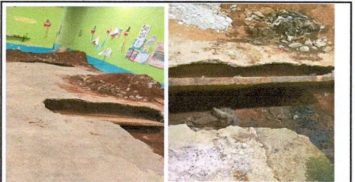
Foto 4: reparación de red de drenaje y red de agua potable. 14.6 limpieza de fosa séptica
