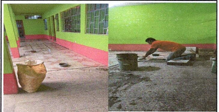
Foto2: PISO 6.8 Sustitución de piso cerámico
