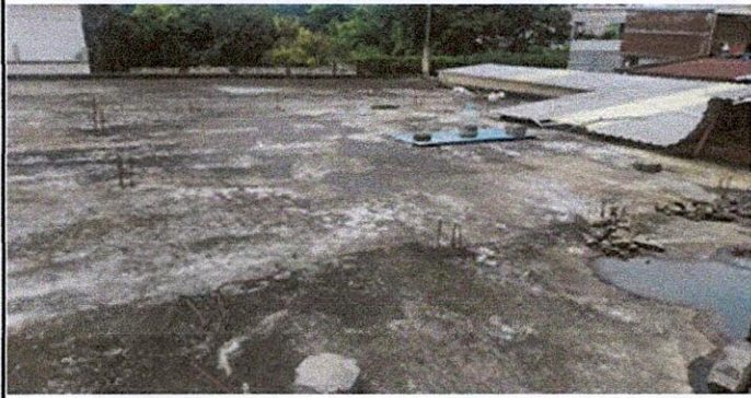
Foto 1: IPERMIABILIZACIÓN DE LOSA 3.1 Ipermiabilización de losa
