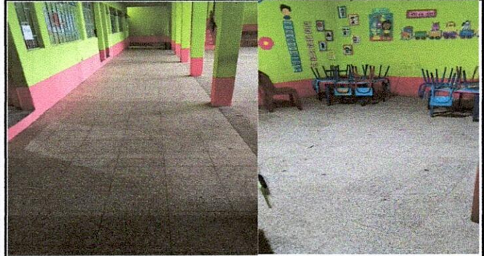
Foto2: PISO 6.8 Sustitución de piso cerámico
