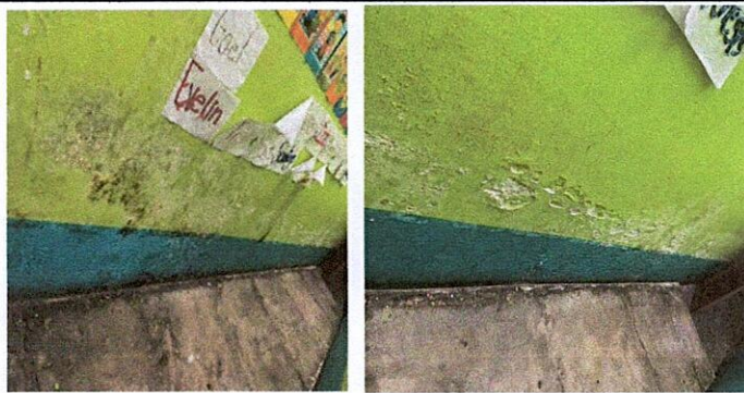
Foto 3: 9.1 Pintura en muros exteriores e interiores
