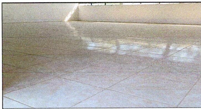
Foto 5: 6.8 Sustitución de piso cerámico
