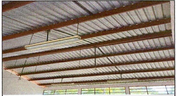
Foto 2: 2.1 Mantenimiento a estructura de soporte de metal
