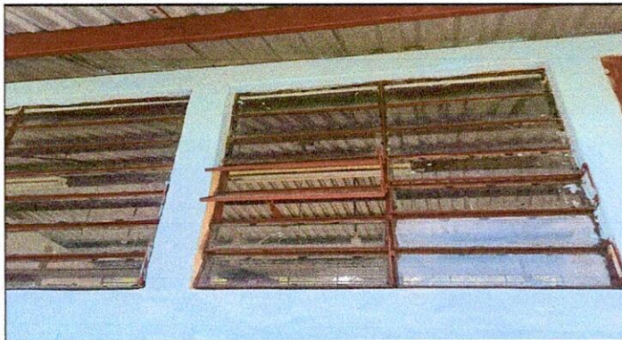
Foto 3:5.1 Mantenimiento a estructura de metal de ventanas
