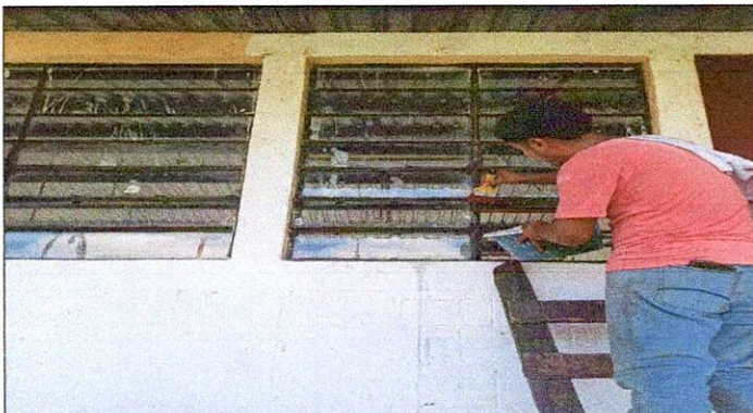
Foto 3:5.1 Mantenimiento a estructura de metal de ventanas
