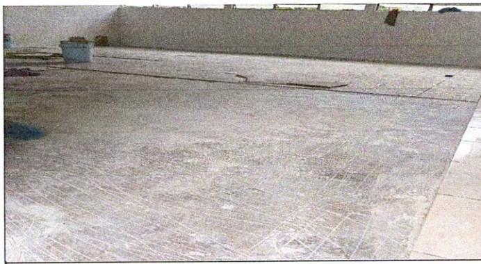
Foto 5: 6.8 Sustitución de piso cerámico
