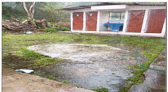
Foto 4: 6.5 Sustitucion de piso de torta de concreto
