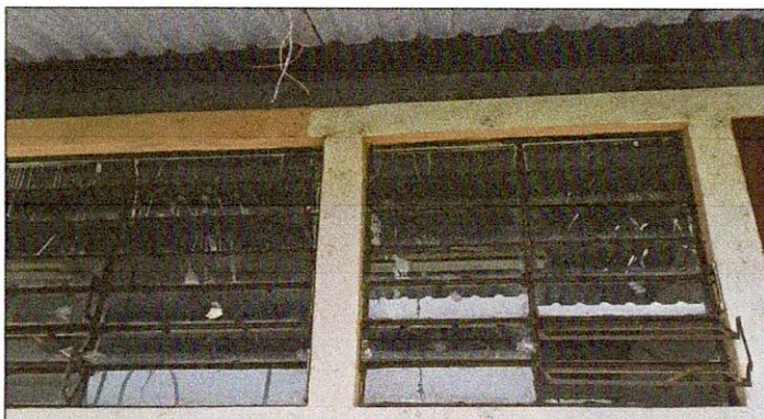
Foto 3:5.1 Mantenimiento a estructura de metal de ventanas
