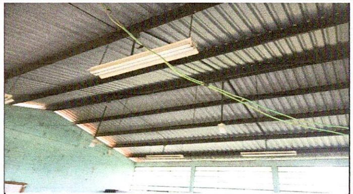
Foto 2: 2.1 Mantenimiento a estructura de soporte de metal
