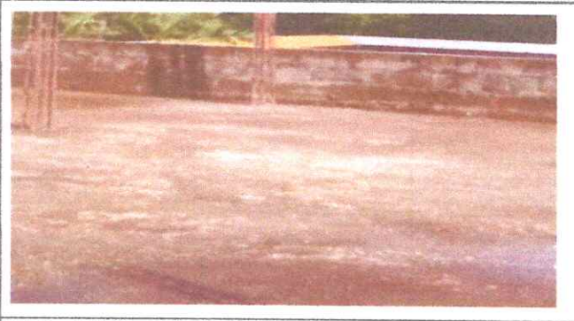
Foto 2: 6- PISO 6.8 Sustitución de piso cerámico
