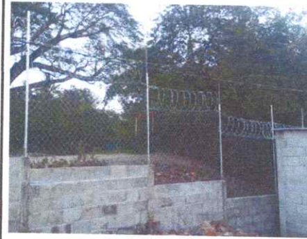
Foto 2: Colocacion de raizor en malla
