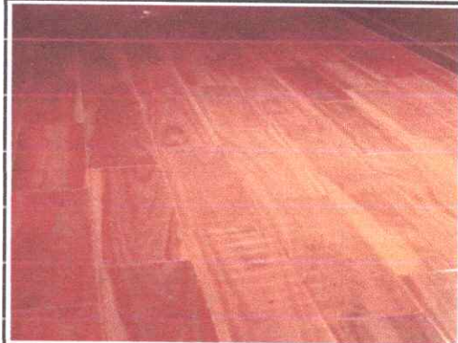
Foto 4: Sustitución de piso ceramico.
