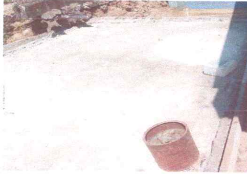
Foto: 7: Reparacion de Cisterna de concreto
