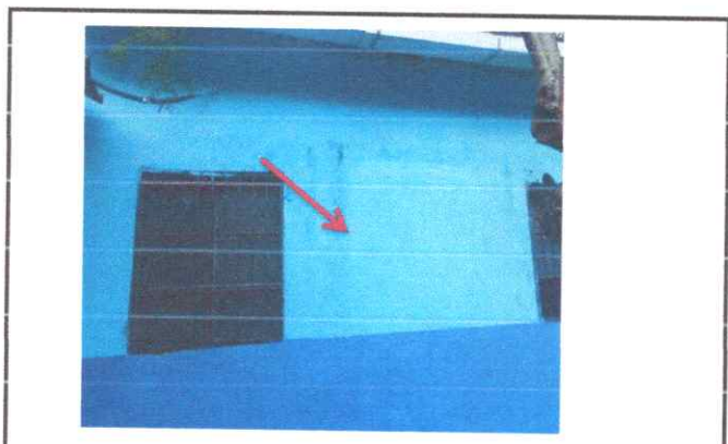
Foto: 11: Sellado de puerta con block y pintado.
