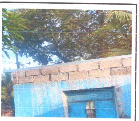
Foto:12: Colocacion de dos filas de block
