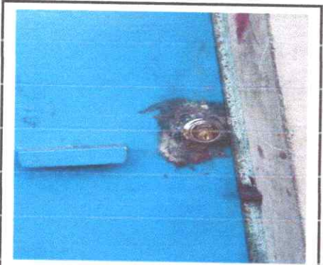
Foto:10: Sustitucion de una chapa.
