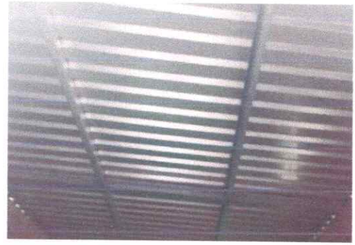
Foto 2: sustitucion de estructura de soporte de metal por metal.
