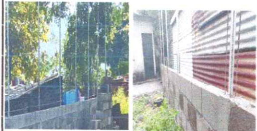
Foto: 6: malla deteriorada se sustituye con tubo hg y malla galvanizada, soleras intermedias y columnas.
