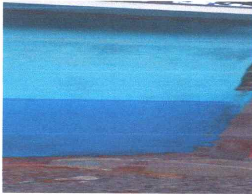
Foto:3: pintura en muros exteriores e interiores
