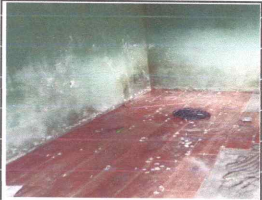
Foto: 4: Sustitución de piso ceramico.
