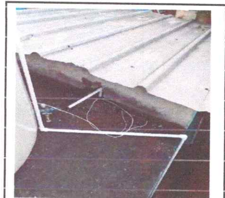
Foto: 8: Instalacion de red de agua potable para tinaco, 9 mts lineales y accesorios para tinaco.
