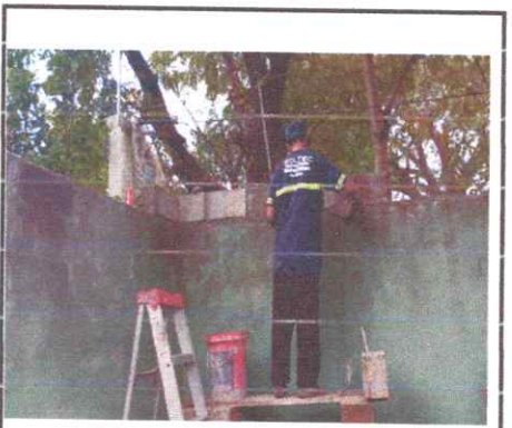
Foto:12:Colocacion de dos filas de block
