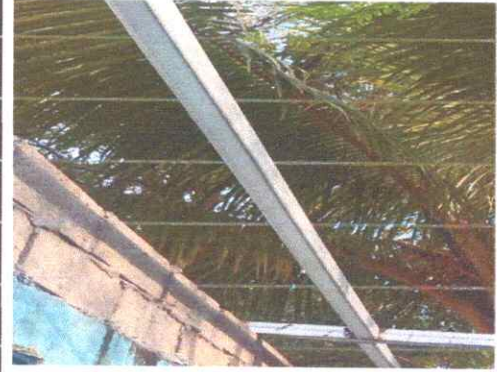
Foto 2: sustitucion de estructura de soporte de metal por metal.
