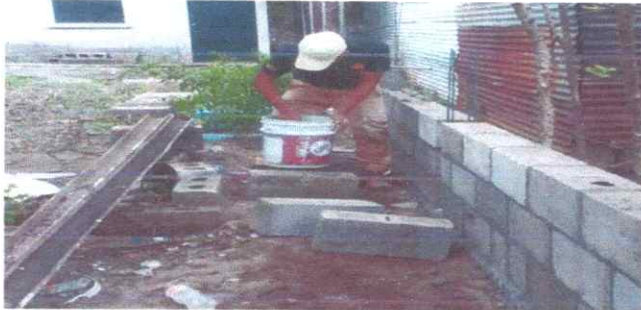
Foto: 5: Reparación de muro perimetral de block.
