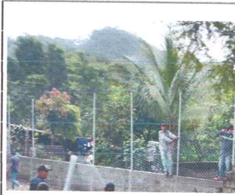
Foto 2: Colocacion de raizor en malla
