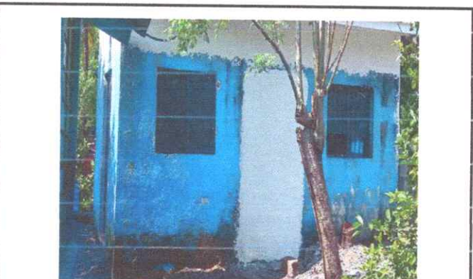
Foto: 11: Sellado de puerta con block y pintado.
