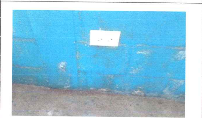
FOTO: 9: Sustitucion de dos tomacorrientes dobles en dos aulas
