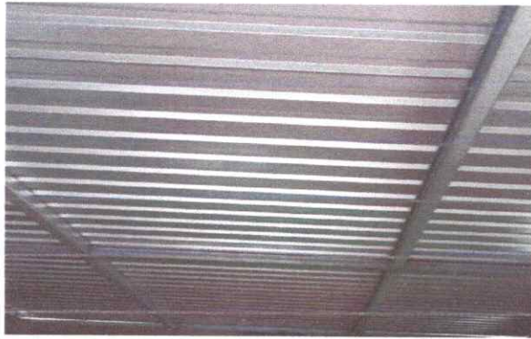
Foto1: sustitución de lamina, por lamina troquelada aluzinc
