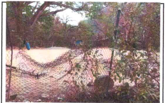
Foto 6: malla deteriorada, se sustituirá con tubo hg y malla galvanizada, soleras intermedias y columnas.
