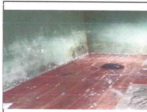
Foto 6: colocacion de 8 mL de piso Ceramica en los zocalos.
