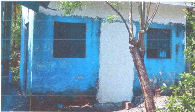
Foto 3: colocacion de canal de metal con bajada de agua pluvial, tuvo pvc 3''
