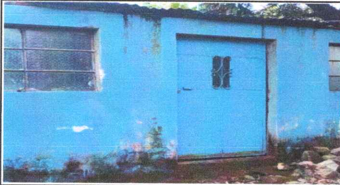
Foto 3: Pintura en Muro Exterior e Interior
