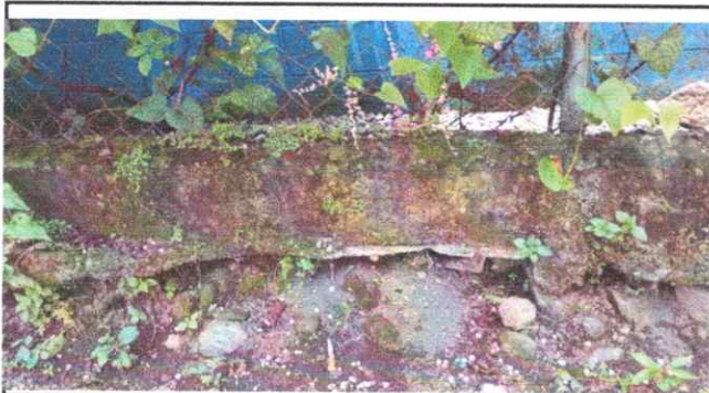
Foto 5: Reparacion de muro perimetral de block.
