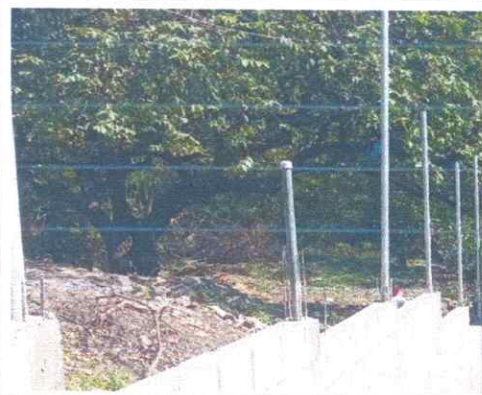
Foto 2: Colocacion de raizor en malla
