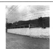
Foto 5: LA MALLA DEL MURO PERIMETRAL ESTA DAÑADA Y A BAJA ALTURA
