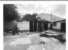
Foto1: LA PILA SE ENCUENTRA DAÑADA PRESENTA RAJADURAS, TECHO Y LAMINAS EN MAL ESTADDO
