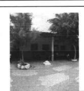
Foto 12: MÓDULO DE AULAS SIN CANAL Y BAJADAS DE AGUA, LAMINAS EN MAL ESTADO
