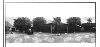
Foto 3: DE IZQUIERDA A DERECHA MÓDULO DE ADMINISTRACIÓN, SANITARIOS Y MÓDULO DE AULAS NINGUN TECHO TIENE CANAL Y BAJADAS DE AGUA
