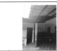
Foto 4: MÓDULO DE AULAS NO TIENEN CANAL Y BAJADAS DE AGUA PLUVIAL ADEMAS LAMINAS EN MAL ESTADO Y ESTRUCTURA METALICA CON OXIDO
