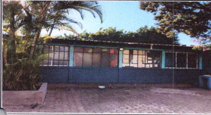
Foto 1: Sustitución de estructura de metal de ventanas
