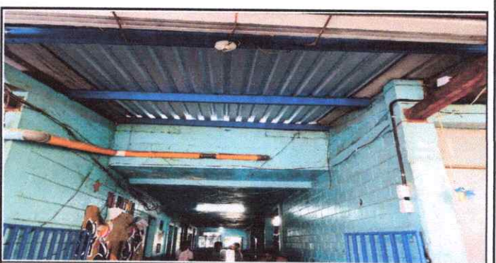
Foto 6: Sustitución de lámina, por lámina troquelada
