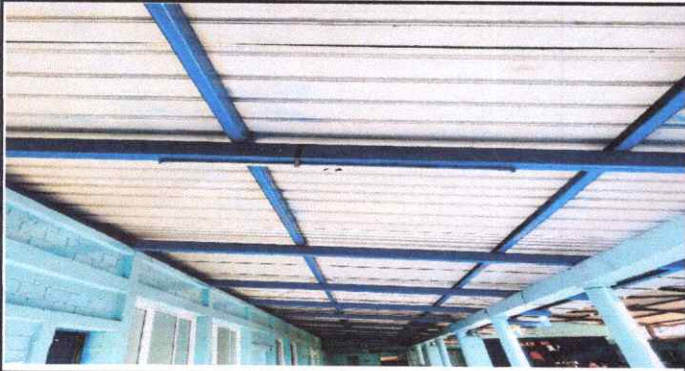
Foto 3: Mantenimiento a estructura de soporte de metal
