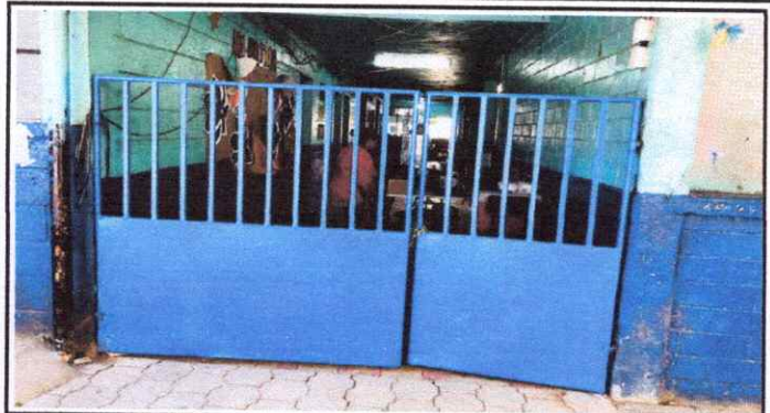
Foto 2: Mantenimiento a estructura de metal
