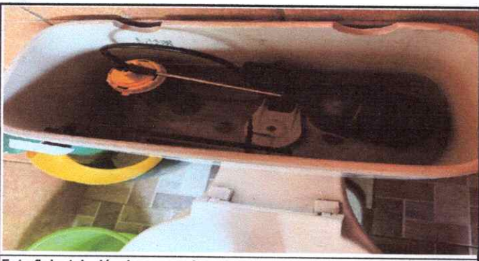
Foto 5: Instalación de accesorios a inodoros
