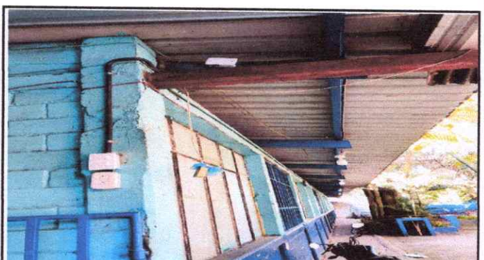
Foto 4: Instalación de ducto eléctrico y accesorios
