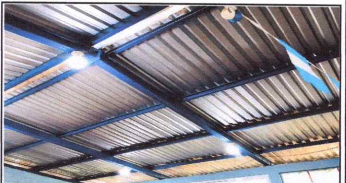
Foto 4: Mantenimiento a estructura de soporte de metal
