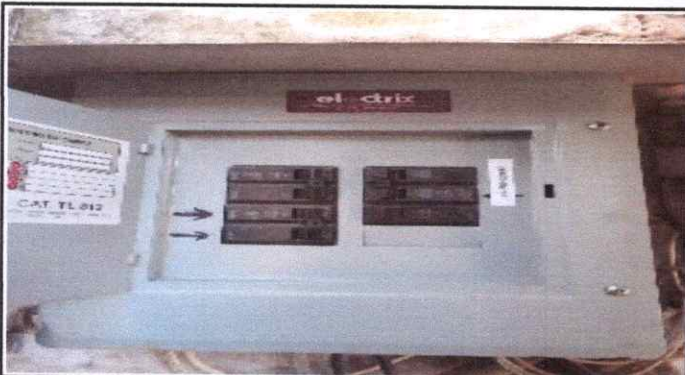
Foto 3: Instalación de flipones en caja principal
