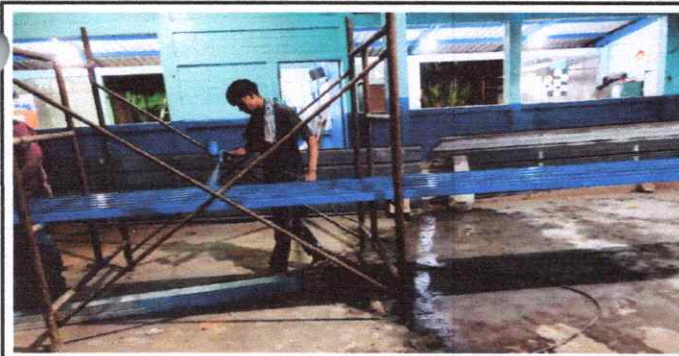
Foto 5: Sustitución de estructura de soporte de metal
