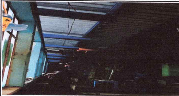
Foto 3: Sustitución de estructura de soporte de metal
