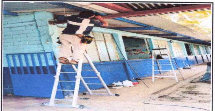
Foto 4: Instalación de ducto eléctrico y accesorios
