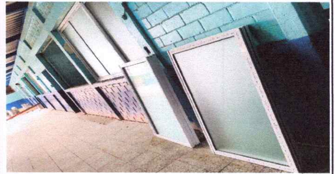
Foto 2: Colocación de ventanas pvc
