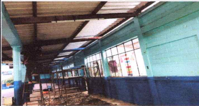
Foto 3: Mantenimiento a estructura de soporte de metal
