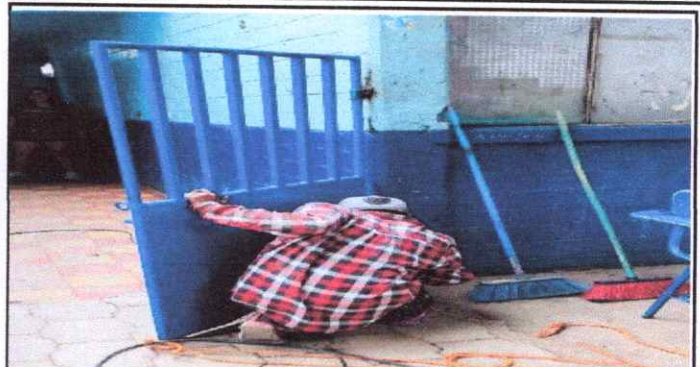
Foto 2: Mantenimiento a estructura de metal
