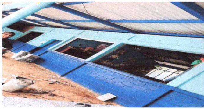
Foto 1: Sustitución de estructura de metal de ventanas
