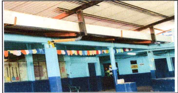
Foto 6: Sustitución de estructura de soporte de metal ya que se encuentra en mal estado.
