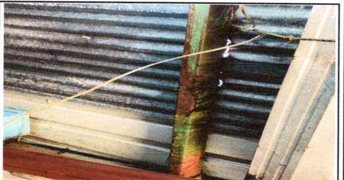
Foto 12: Sustitución de lámina, por lámina troquelada, se encuentra en mal estado.
