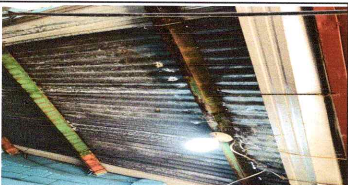
Foto 11: Sustitución de lámina, por lámina troquelada, se encuentra en mal estado.
