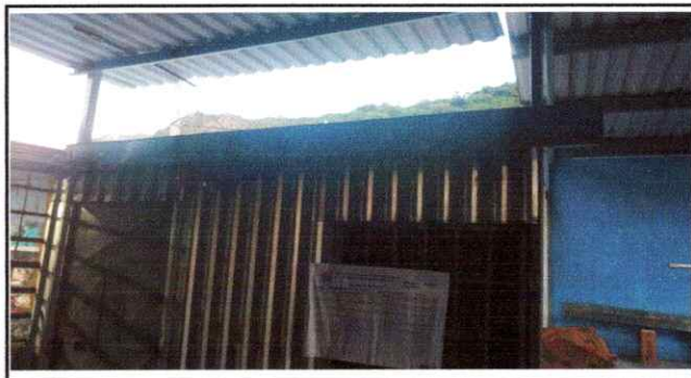
Foto 11: Instalación de canal de metal finalizado.
