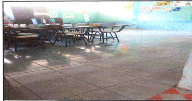
Foto 6: Finalización de Instalación de piso cerámico.
