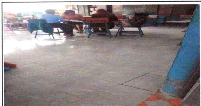
Foto 3: Finalización de Instalación de piso cerámico.
