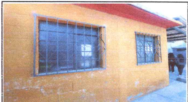
Foto 16: Instalación de Balcones de Metal finalizado.
