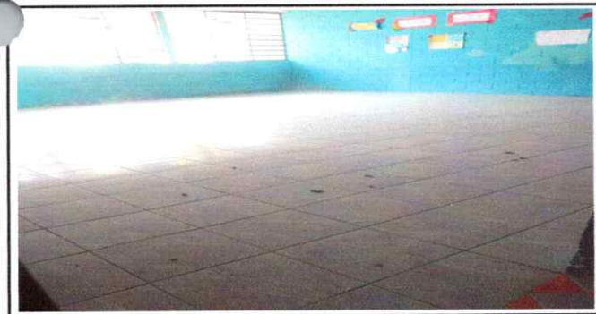
Foto 5: Finalización de Instalación de piso cerámico.
