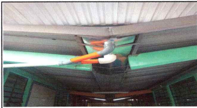
Foto 9: Sustitución de canal de metal en el pasillo finalizado.
