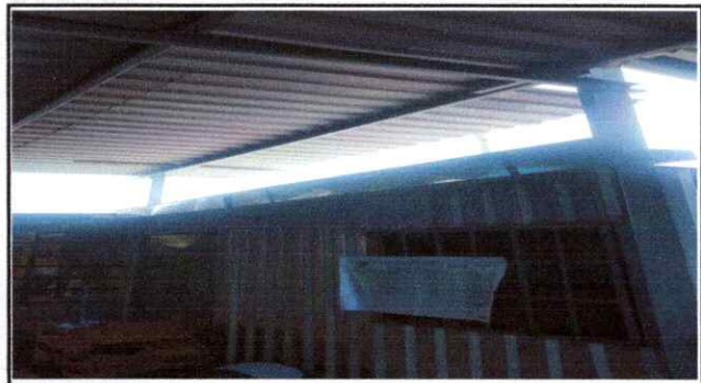
Foto 10: Instalación de canal de metal finalizado.
