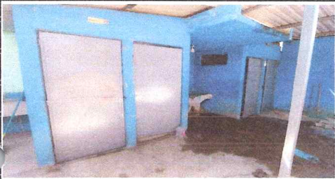
Foto 13: Mantenimiento de puertas de sanitarios finalizado.
