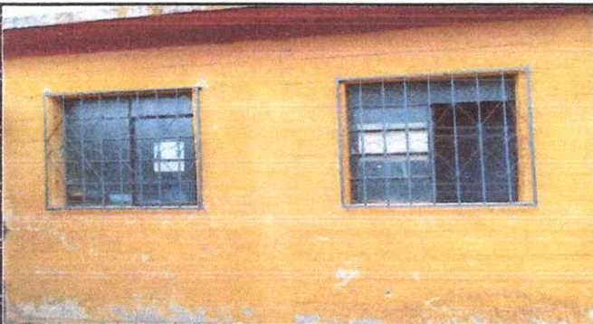
Foto 15: Instalación de Balcones de Metal finalizado.
