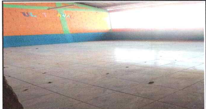
Foto 4: Finalización de Instalación de piso cerámico.
