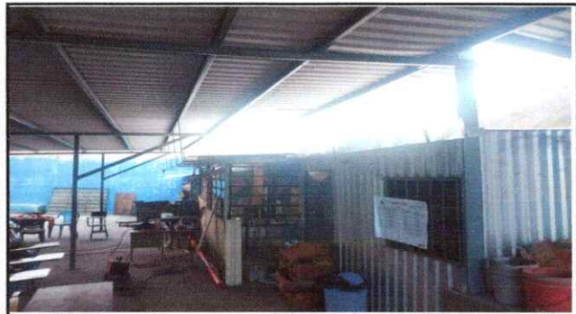
Foto 12: Bajada de agua plubial de metal por tuvo PVC finalizado.
