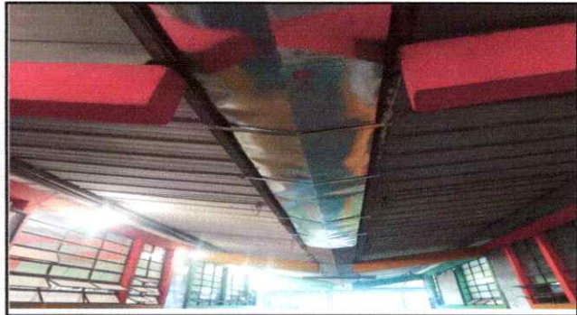
Foto 8: Sustitución de canal de metal en el pasillo finalizado.
