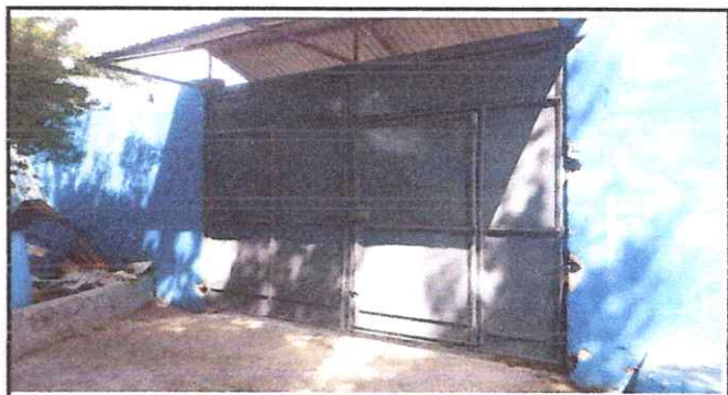
Foto 18: Mantenimiento de Porton de metal finalizado.
