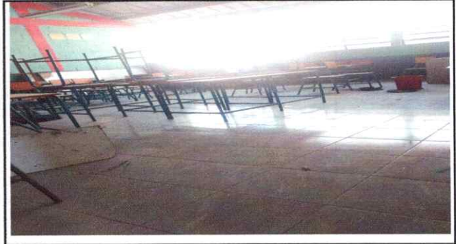
Foto 2: Finalización de Instalación de piso cerámico.
