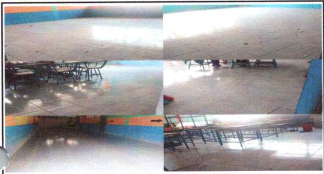
Foto 1: Finalización de Instalación de piso cerámico.
