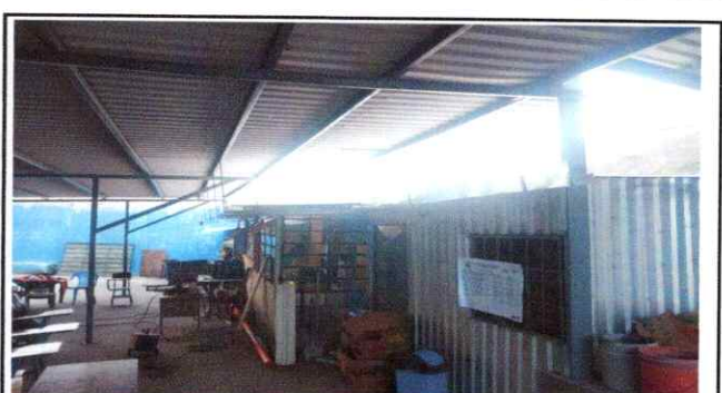
Foto 12: inicio de bajada de agua plubial de metal por tuvo PVC
