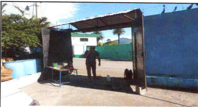
Foto 23: Inicio de mantenimiento de Porton de metal
