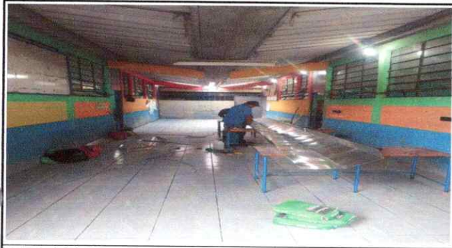
Foto 7: inicio de sustitucion de canal de metal en el pasillo
