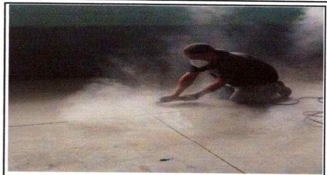
Foto 2: Inicio de Instalación de piso cerámico
