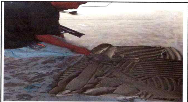
Foto 3: Inicio de Instalación de piso cerámico
