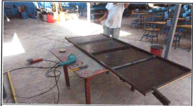
Foto 16: Inicio de matenimiento de puertas de sanitarios
