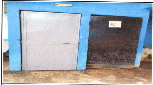
Foto 14: Inicio de matenimiento de puertas de sanitarios
