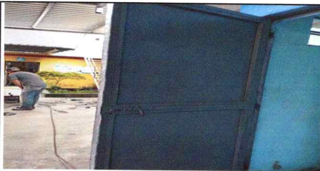
Foto 15: Inicio de matenimiento de puertas de sanitarios
