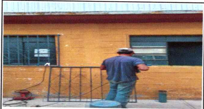
Foto 20: Instalación de Balcones de Metal
