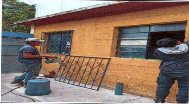
Foto 19: Instalación de Balcones de Metal
