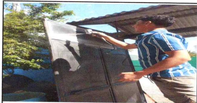
Foto 24: Inicio de mantenimiento de Porton de metal
