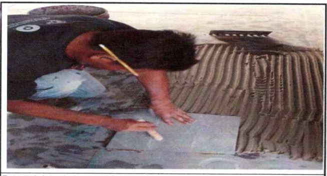
Foto 5: Inicio de Instalación de piso cerámico
