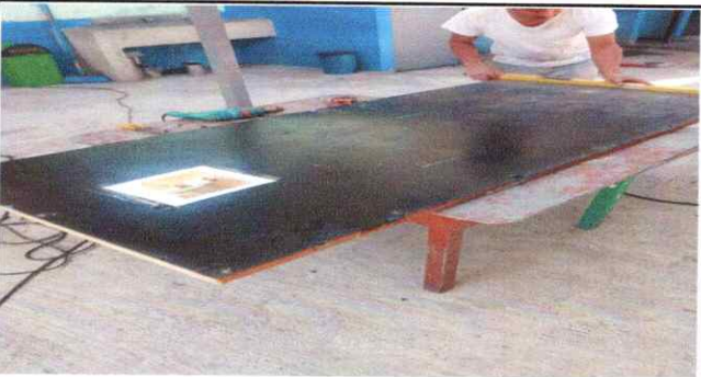
Foto 17: Inicio de matenimiento de puertas de sanitarios
