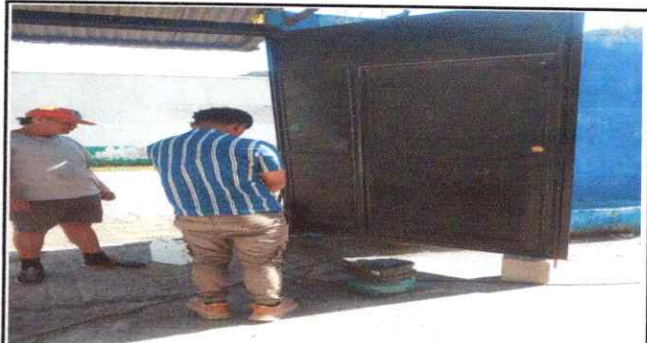
Foto 22: Inicio de mantenimiento de Porton de metal
