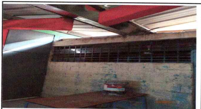
Foto 10: inicio de sustitucion de canal de metal en el pasillo
