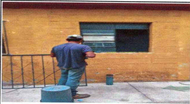
Foto 21: Instalación de Balcones de Metal
