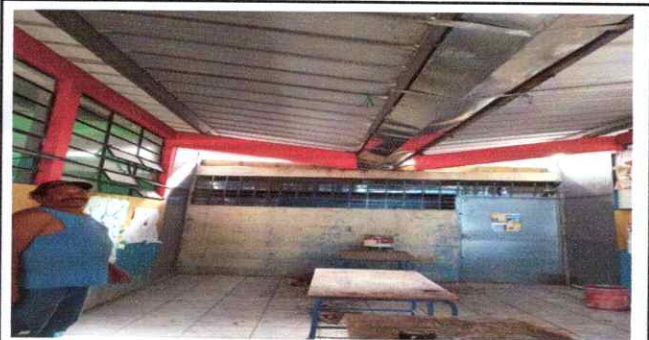
Foto 9: inicio de sustitucion de canal de metal en el pasillo
