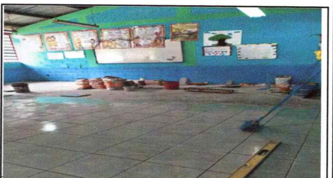
Foto 6: Inicio de Instalación de piso cerámico
