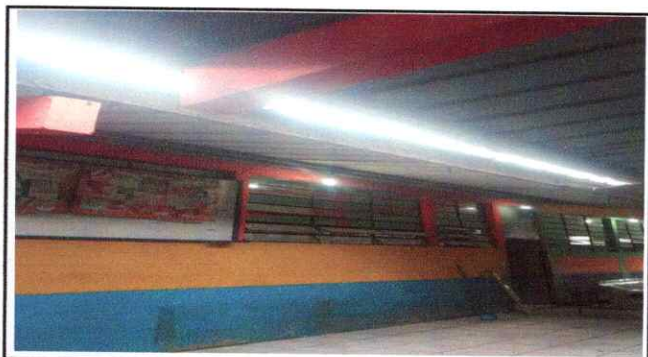
Foto 8: inicio de sustitucion de canal de metal en el pasillo
