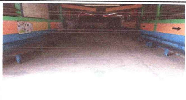
FOTO 2: PASILLO DEL ESTABLECIMIENTO, SUSTITUCIÓN DE PISO CERAMICO
