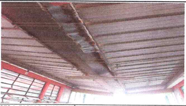
FOTO 3: PASILLO, SUSTITUCIÓN DE CANAL DE METAL
