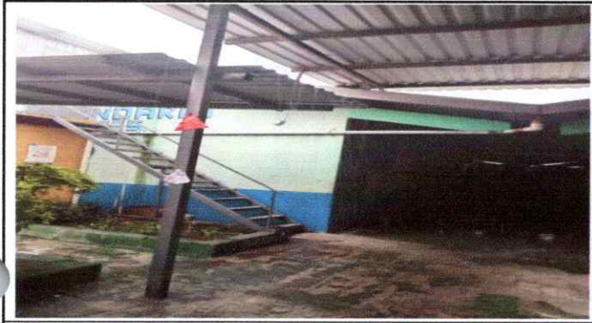
FOTO 7: SUSTITUCIÓN DE BAJADA DE AGUA PLUVIAL DE METAL, POR TUVO PVC
