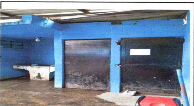
FOTO 10: MANTENIMIENTO DE PUERTAS DE SANITARIOS
