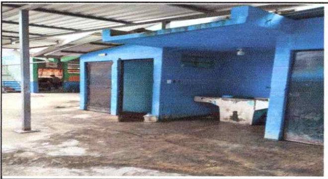
FOTO 9: MANTENIMIENTO DE PUERTAS DE SANITARIOS
