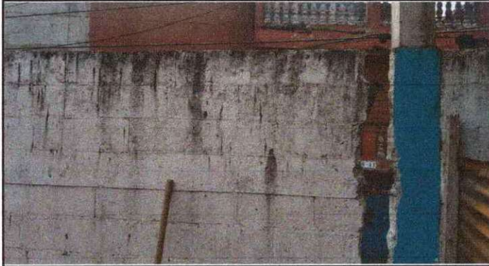
Foto 1: Muro perimetral de block, área interior
