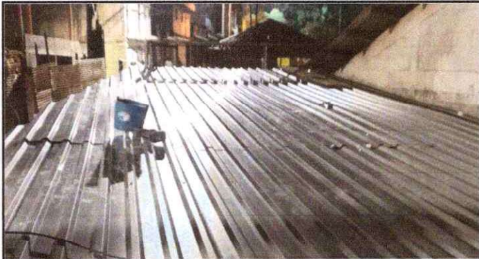
Foto 3: Instalación de lámina troquelada, área exterior de cocina
