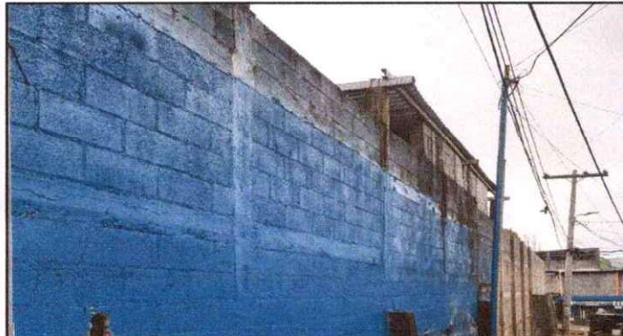
Foto 3: Pintura en muro perimetral, area exterior
