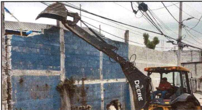
Foto 3: Muro perimetral de block y de contención, área exterior
