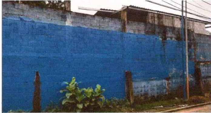
Foto 1: Pintura en muro perimetral, area exterior
