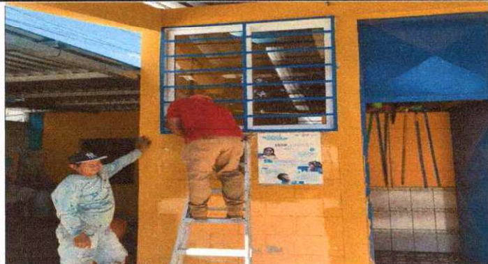
Foto 1: Mantenimiento a estructura de metal de ventana
