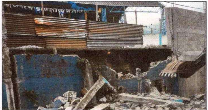
Foto 4: Muro perimetral de block y de contención, área exterior.
