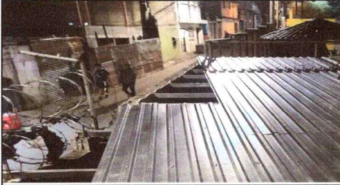
Foto 1: Instalación de lámina troquelada , área interior de cocina
