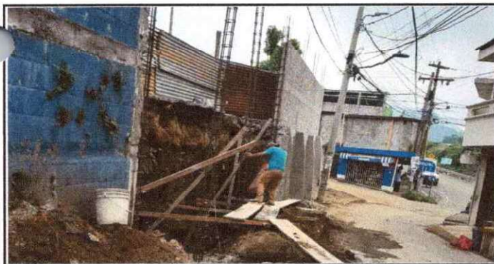
Foto 5: Muro perimetral de block y de contención, área exterior.
