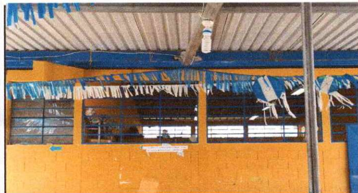
Foto 3: Mantenimiento a estructura de metal de ventana
