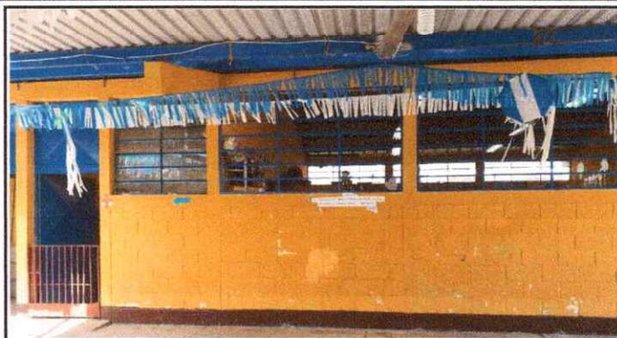
Foto 2: Mantenimiento a estructura de metal de ventana
