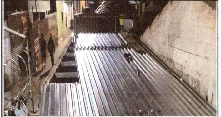
Foto 2: Instalación de lámina troquelada, área interior de cocina.
