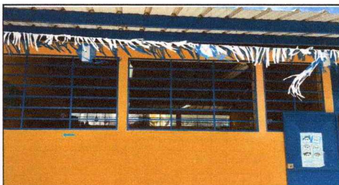
Foto 4: Mantenimiento a estructura de metal de ventana
