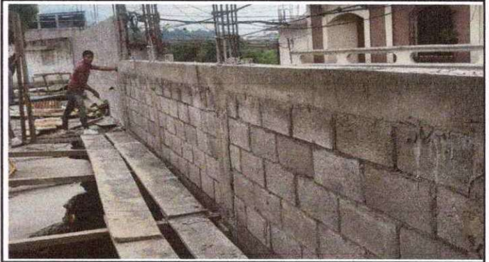
Foto 2: Muro perimetral de block, área interior.
