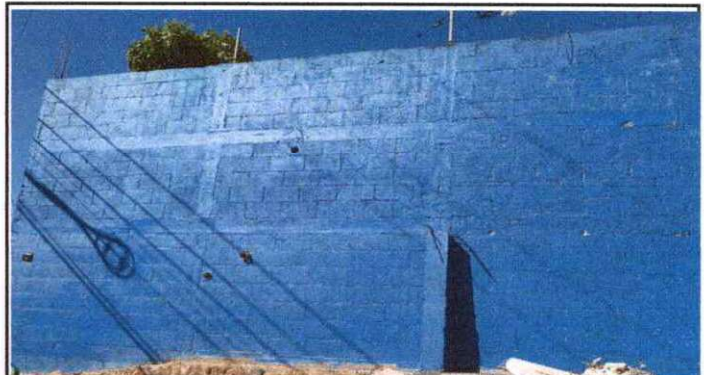
Foto 4: Pintura en muro perimetral, area exterior
