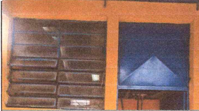
Foto 1: Mantenimiento en estructura de metal de ventana que se utilizará como balcon
