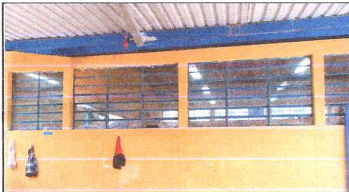
Foto 3: Mantenimiento en estructura de metal de ventana que se utilizará como balcon.
