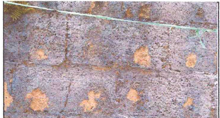
Foto 4: Reparación de muro perimetral de block y de contención
