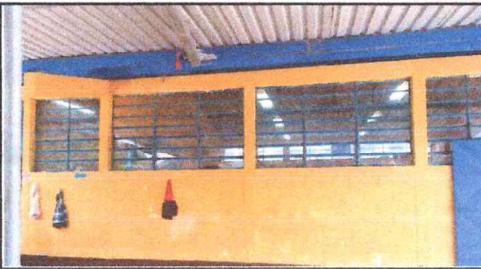
FOTO 3: Instalación de energía eléctrica en el corredor.
