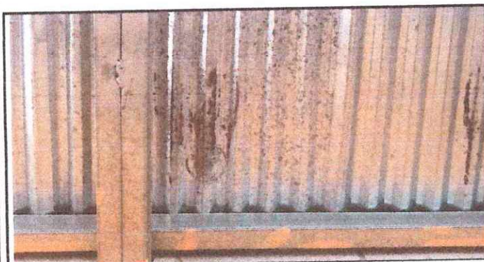
Foto 5: Desinstalación y Sustitución de lámina por troquelada
