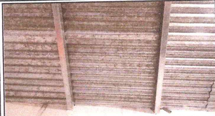
Foto 1. Desinstalación y Sustitución de lámina por troquelada
