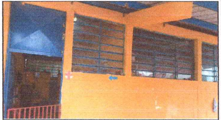
Foto 2: Sustrucción de ventanas
