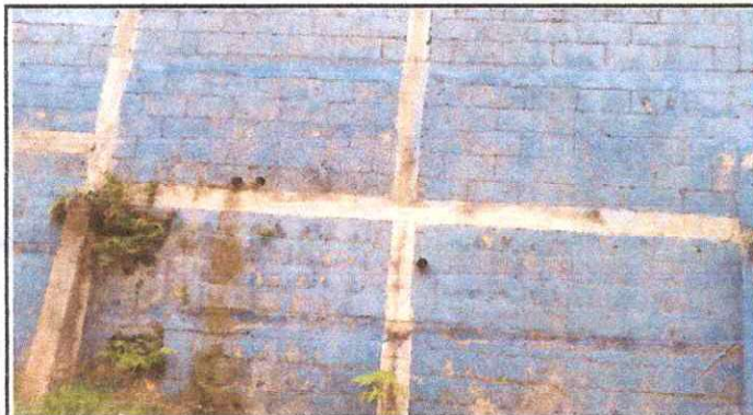
Foto 3: Reparación de muro perimetral de block y de contención
