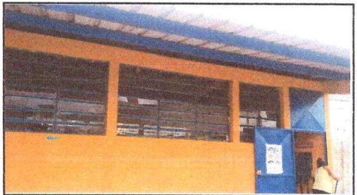
FOTO 4: Instalación de energía eléctrica en el corredor
