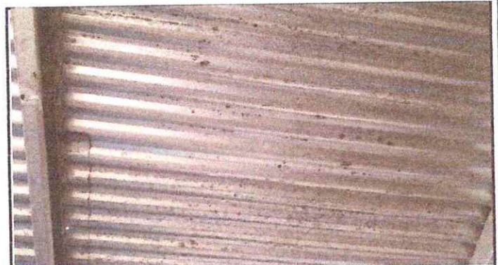
Foto 4: Desinstalación y Sustitución de lámina por troquelada
