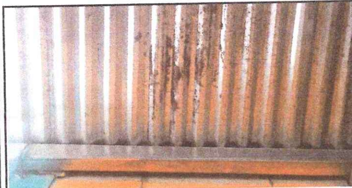
Foto 3: Desinstalación y Sustitución de lámina por troquelada
