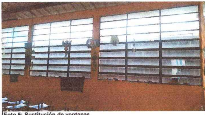
Foto 5: Sustrucción de ventanas
