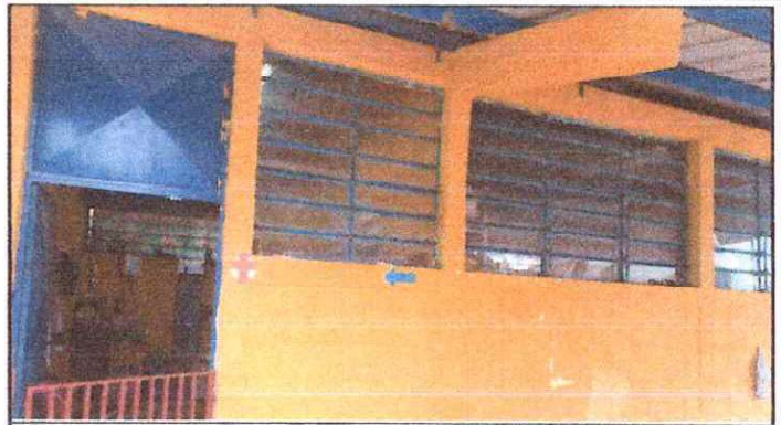
Foto 2: Mantenimiento en estructura de metal de ventana que se utilizara como balcon.
