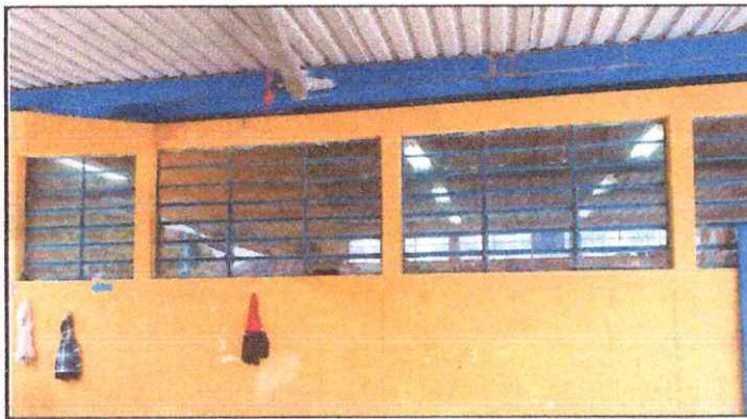
Foto 3: Sustrucción de ventanas
