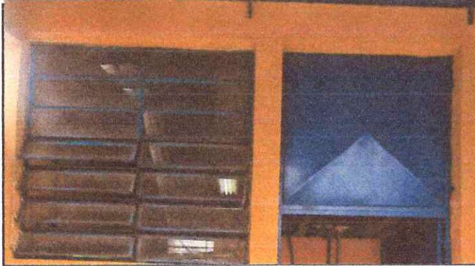
FOTO 1: Sustrucción de ventanas
