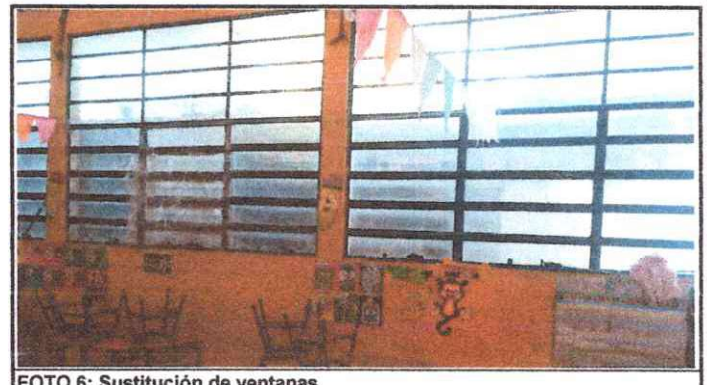
FOTO 6: Sustrucción de ventanas
