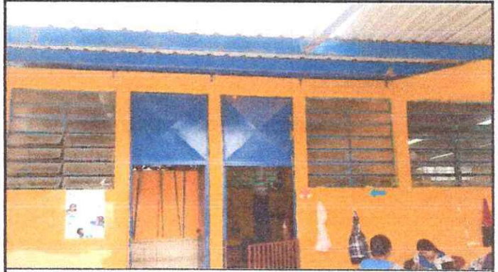
Foto 2: Instalación de energía eléctrica en el corredor
