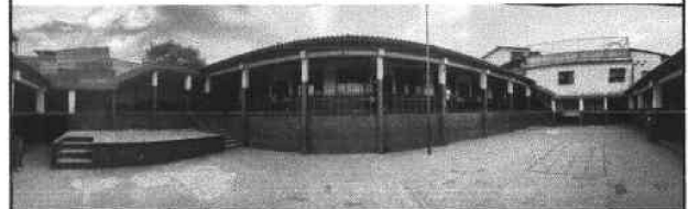
Foto 4: VISTA DEL MÓDULO DE AULAS SIN BAJADAS DE AGUA PLUVIAL Y ESCENARIO
