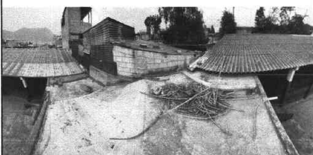
Foto 5: VISTA DE LA LOSA MÓDULO DE GRADAS, ACTUALMENTE SE GENERA HUMEDAD Y NO TIENE BAJADAS DE AGUA PLUVIAL
