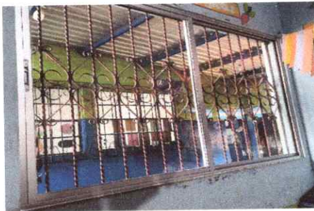
Foto 9: Mantenimiento a estructura de metal.
