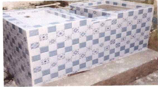
Foto 8: Colocación de azulejo en pila, teniendo un lugar limpio.
