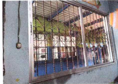
Foto 4: Colocación de ventana aluminio.
