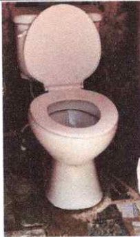
Foto 3: Colocación de sanitarios.
