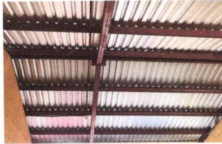
Foto 2: Sustitución de lámina troquelada, pintura en costanera.
