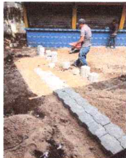
Foto7: Durante la reparación de la losa de patio. Colocación de adoquín
