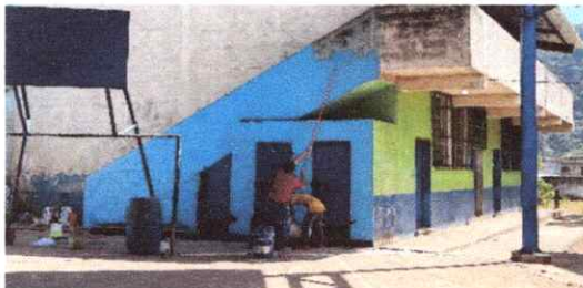
Foto 12: Pintura en muros exteriores.
