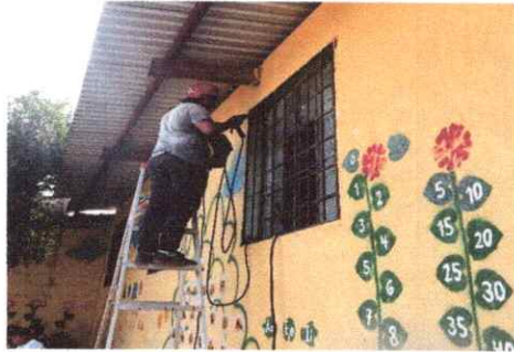
Foto 8: Mantenimiento a ventanas.
