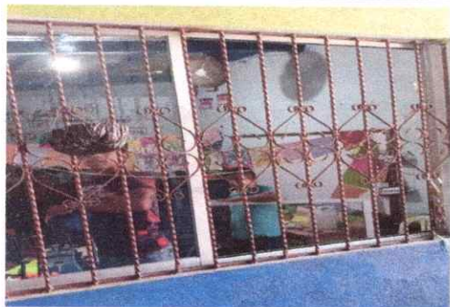
Foto 3: Colocación de ventana de aluminio
