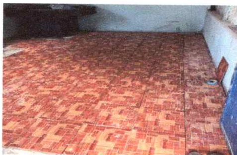
Foto 4: Durante la colocación del piso cerámico en área de cocina.
