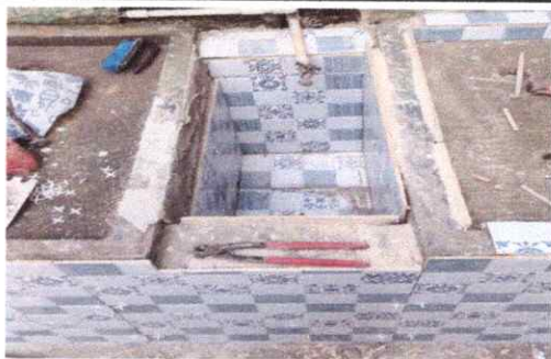
Foto 5: Durante la colocación de azulejo en el área de pila.
