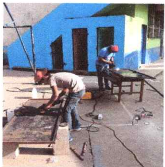
Foto1: Durante el mantenimiento de puertas, cambio de inodoros.
