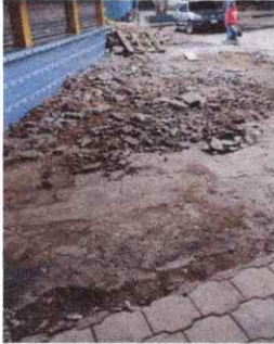
Foto7: Durante la reparación de la losa de patio. Colocación de adoquín
