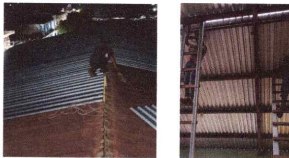
Foto 2: Durante la sustitución de lámina troquelada, mantenimiento de costaneras.
