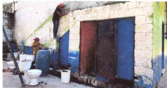
Foto 10: Durante la colocación de sanitarios
