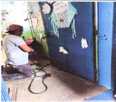
Foto 9: Mantenimiento a puertas de salones.
