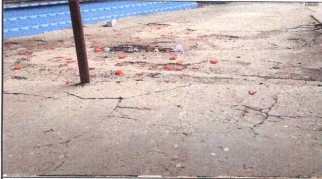
Foto 7: Loza de patio, reparación de concreto a adoquín
