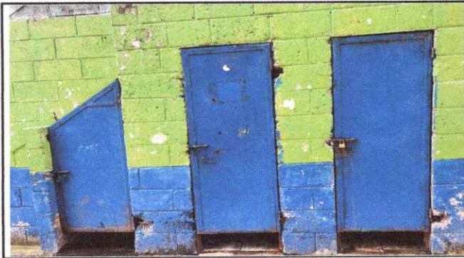
Foto 1: Mantenimiento de puertas, cambio de Inodoros y colocación de azulejos
