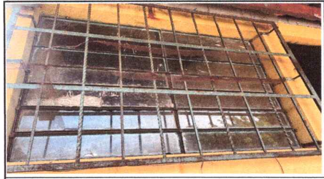
Foto 4: Mantenimiento a estructura de metal de ventana
