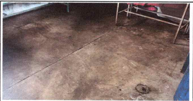
Foto 11: Sustitución de piso ceramico
