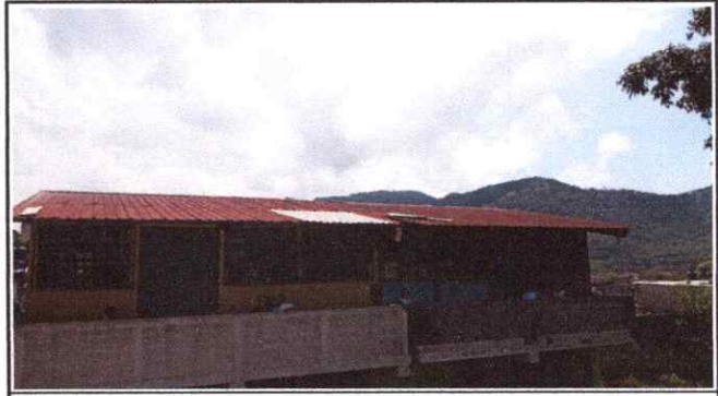
Foto 2: Sustitución lamina por lamina troquelada, repello y cernido de muros exteriores y reparación de sistema electrico
