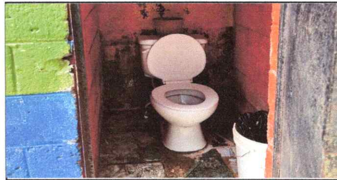
Foto 6: Cambio de inodoro y colocación de azulejos
