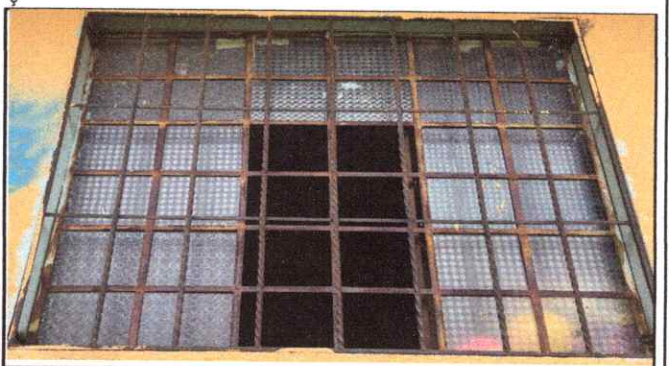
Foto 10: Mantenimiento a estructura metal de ventana
