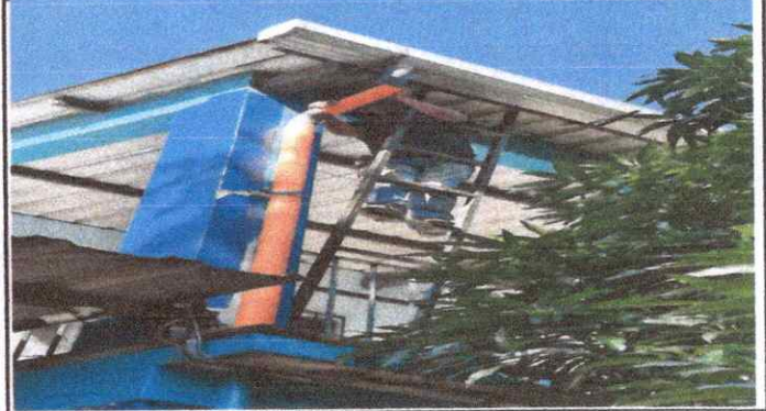
Foto 2: Reparación de bajade de agua pluvial tubo PVC 3"
