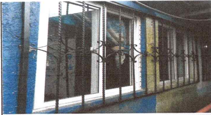
Foto 3: Mantenimiento a balcones de metal.
