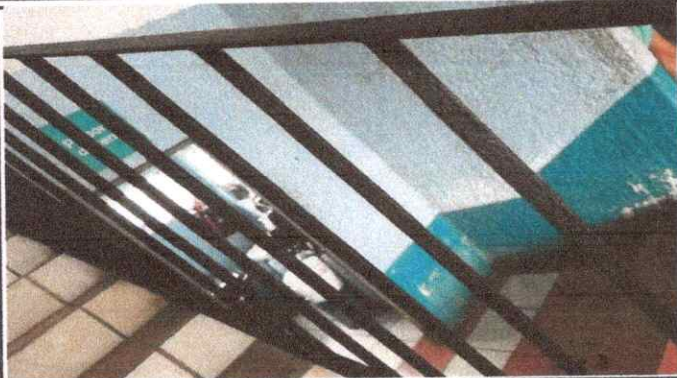
Foto 1: Mantenimiento a barandas de metal
