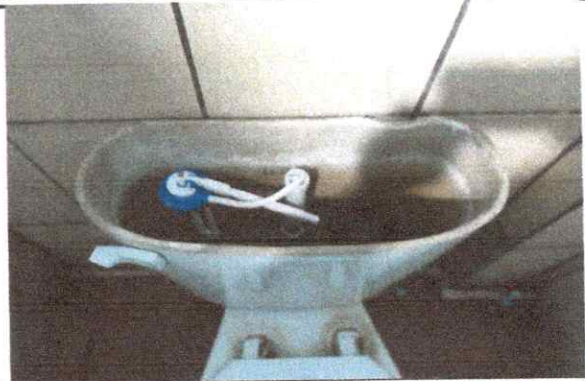
Foto 2: Sustrucción de accesorios inodoro (contra llave, tubo de abasto y tanque)
