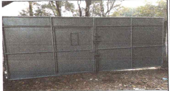
Foto 2: Mantenimiento a portones de metal
