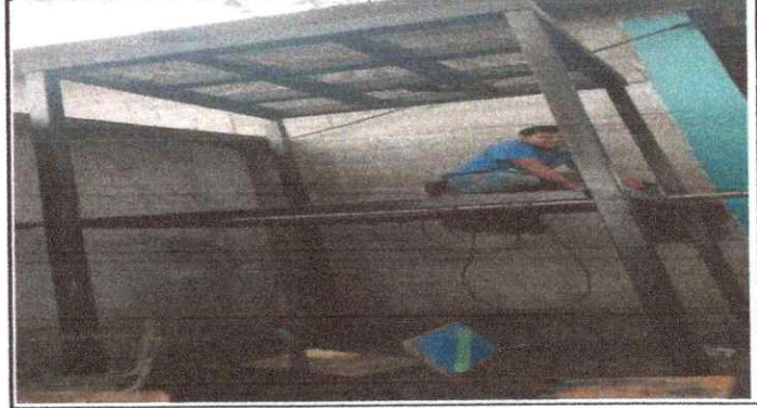
Foto 2: Instalación de estructura portante de metal
