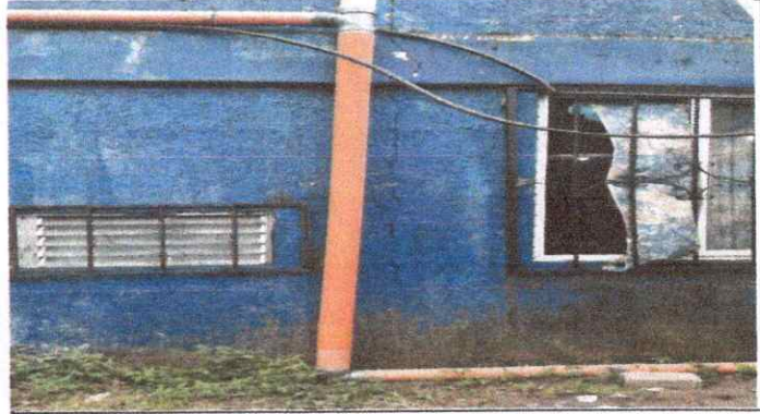
Foto 4: Reparación de baja de agua pluvial tubo PVC 3"
