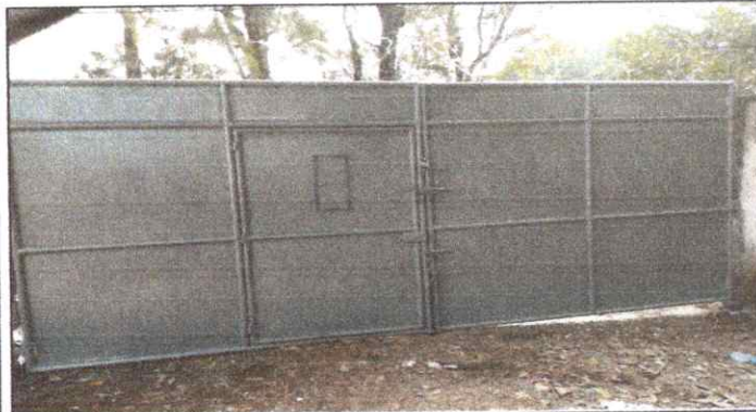
Foto 3: Mantenimiento a portones de metal
