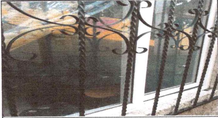
Foto 1: Mantenimiento a balcones de metal.
