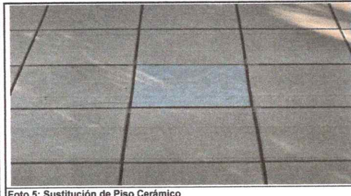
Foto 5: Sustrucción de Piso Cerámico
