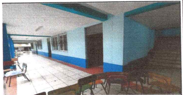
Foto 12: finalización de pintura de exteriores e interiores
