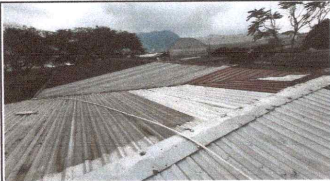
Foto 1: Sustitución de canal de metal
