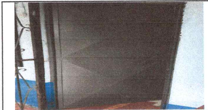
Foto 5: Mantenimiento a estructura, (lijado, cambio de tubo, cepillado, sujeciones, aplicación de pintura)
