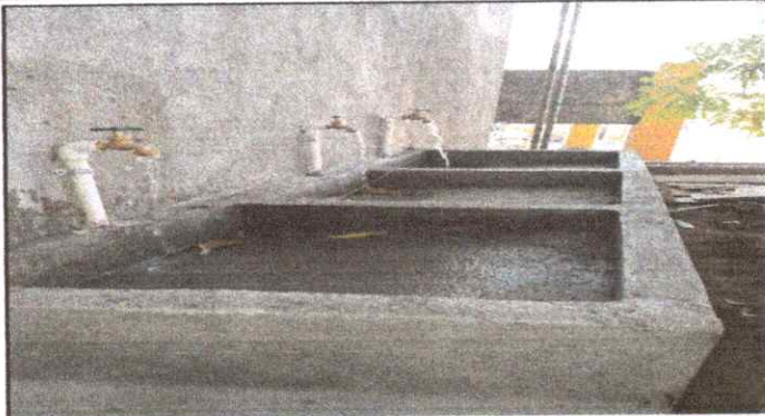
Foto 1: Instalación de tubería para agua potable
