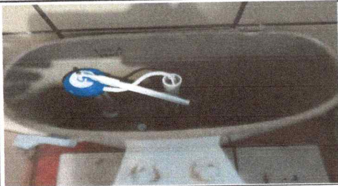
Foto 1: Sustrucción de accesorios inodoro (contra llave, tubo de abasto y tanque)
