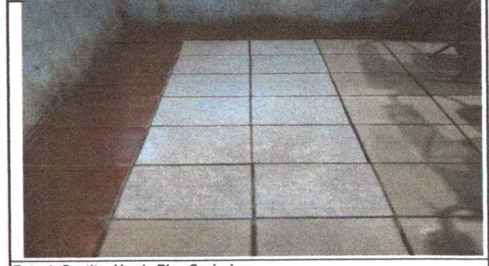
Foto 4: Sustrucción de Piso Cerámico
