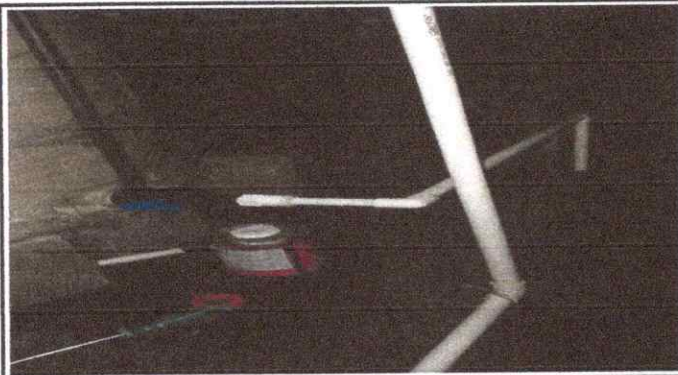
Foto 3: Instalación de tubería para agua potable
