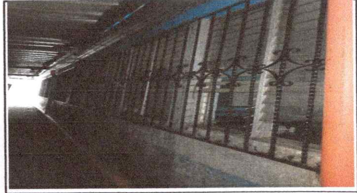
Foto 4: Mantenimiento a balcones de metal
