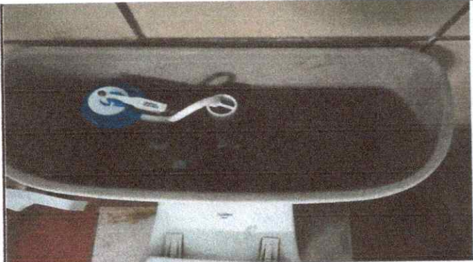
Foto 3: Sustrucción de accesorios inodoro (contra llave, tubo de abasto y tanque)
