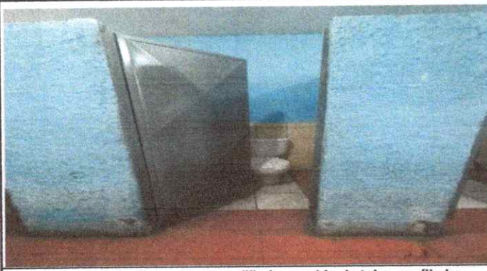
Foto 1: Mantenimiento a estructura, (lijado, cambio de tubo, cepillado, sujeciones, aplicación de pintura)
