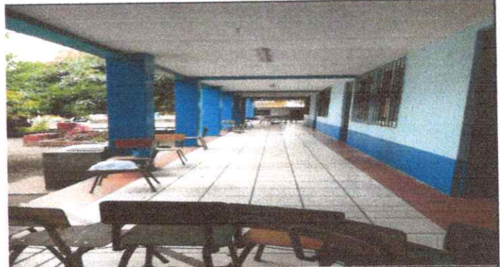
Foto 10: finalización de pintura de muros exteriores e interiores
