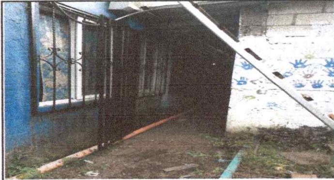
Foto 1: Fabricación e instalación de puerta de rejas
