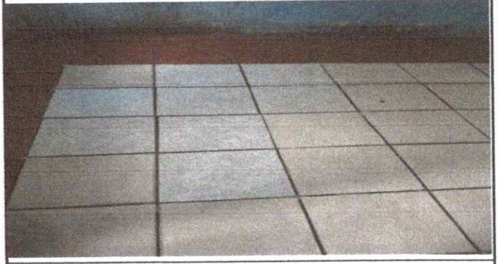
Foto 2: Sustrucción de Piso Cerámico
