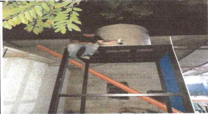
Foto 3: Instalación de estructura portante de metal
