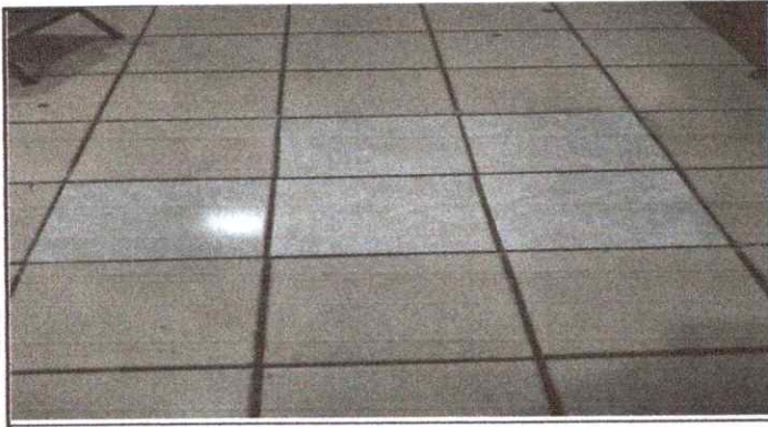
Foto 3: Sustrucción de Piso Cerámico
