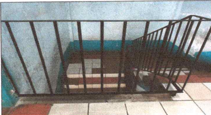
Foto 4: Mantenimiento a barandas de metal
