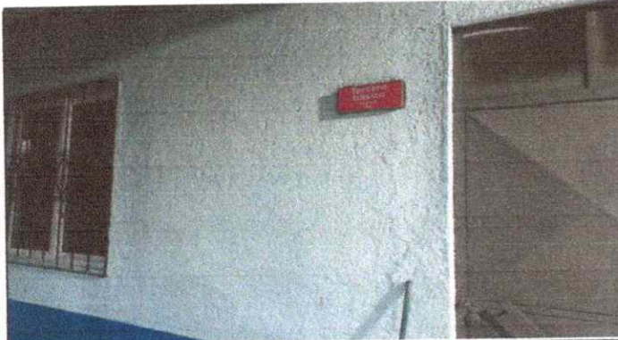
Foto 9: Finalización de pintura de muros exteriores e interiores
