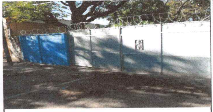
Foto 4: Mantenimiento a portones de metal
