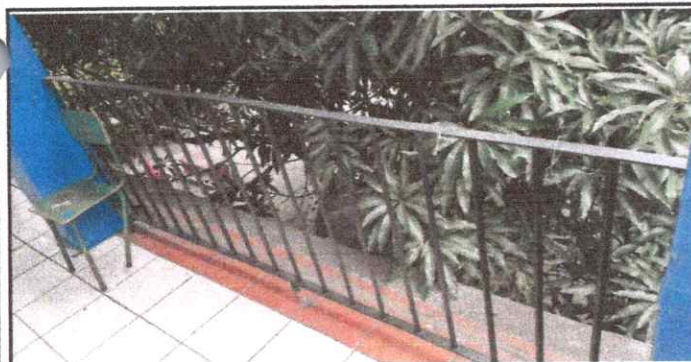
Foto 6: Mantenimiento a barandas de metal
