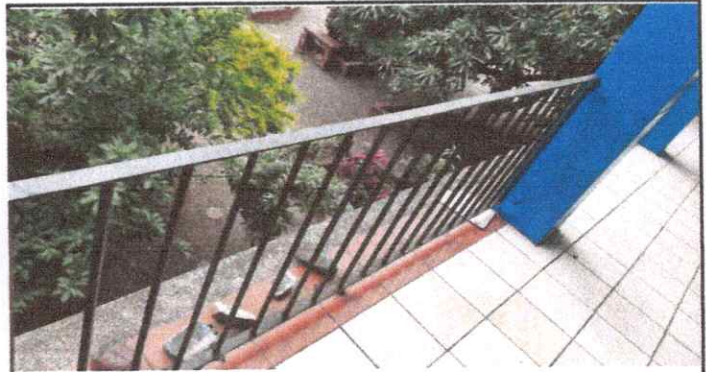
Foto 5: Mantenimiento a barandas de metal
