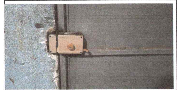
Foto 6: Sustitución de Chapa
