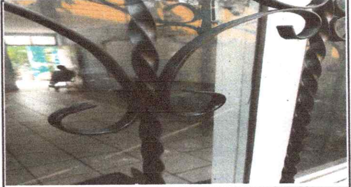
Foto 2: Mantenimiento a balcones de metal.
