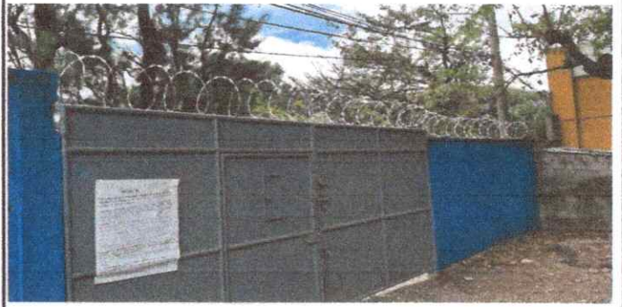
Foto 2: Reparacion de cerco de alambre de pua.
