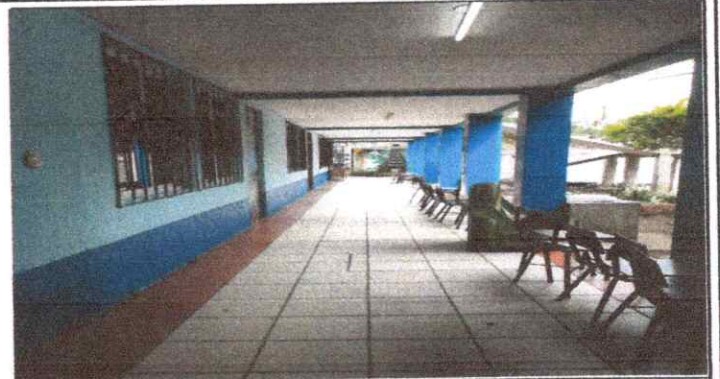
Foto 8: finalización de pintura de muros exteriores e interiores
