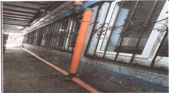
Foto 3: Reparación de baja de agua pluvial tubo PVC 3"
