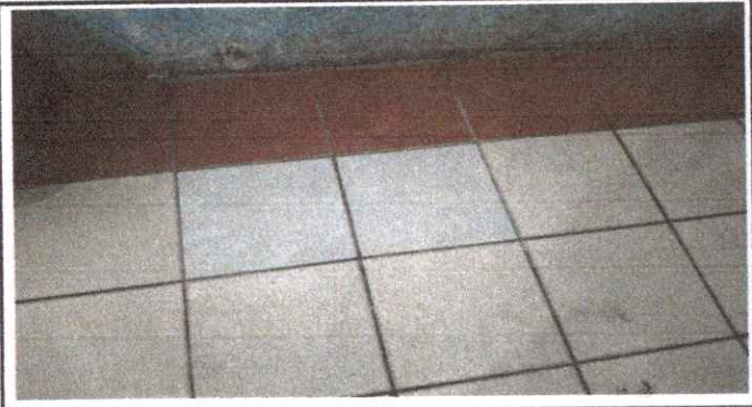
Foto 1: Sustrucción de Piso Cerámico
