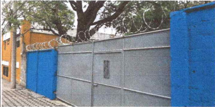
Foto 1: Reparacion de cerco de alambre de pua.
