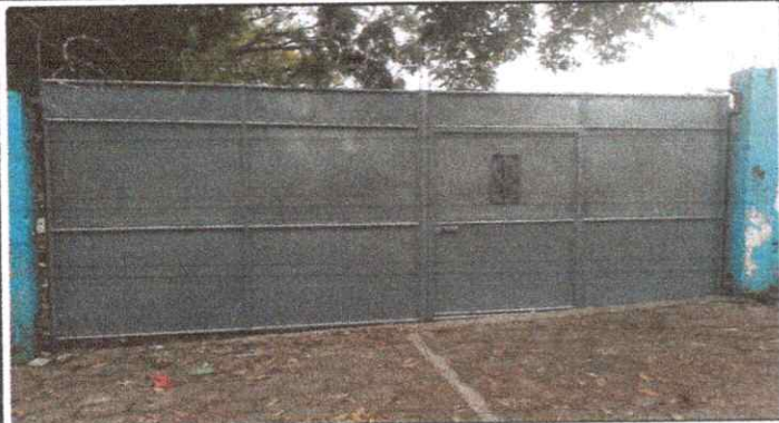
Foto 1: Mantenimiento a portones de metal
