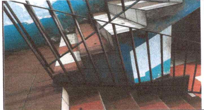
Foto 2: Mantenimiento a barandas de metal
