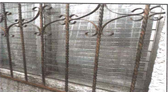
Foto 4: Mantenimiento a balcones de metal.
