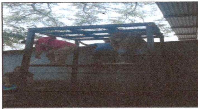
Foto 5: Instalación de estructura portante de metal
