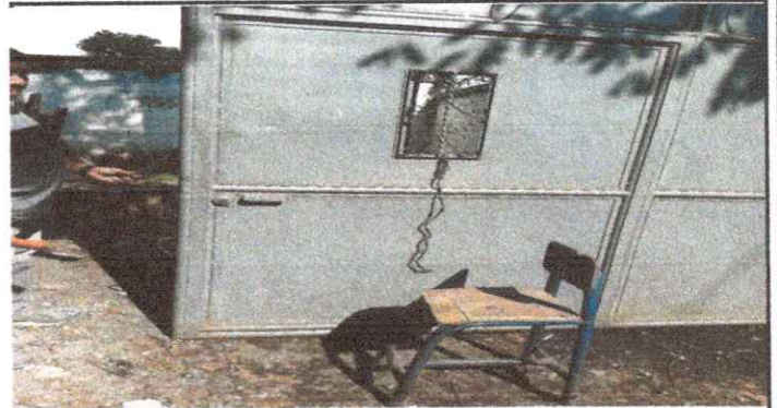
Foto 4: Mantenimiento a portones de metal
