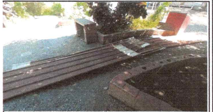
Foto 4: Sustitución de lámina, por lámina troquelada aluzinc calibre 26
