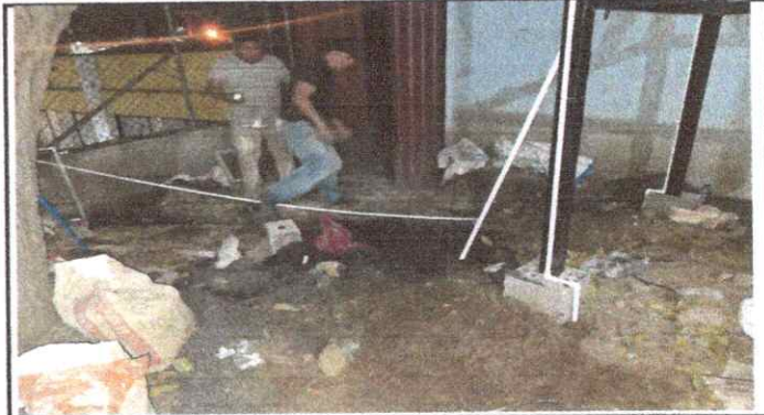
Foto 2: Instalación de tubería para agua potable
