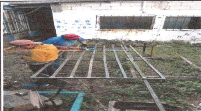
Foto 1: Fabricación e instalación de puerta de rejas
