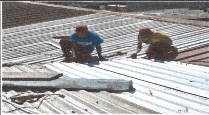
Foto1: Sustitución de canal de metal.
