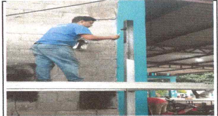
Foto 4: Instalación de estructura portante de metal
