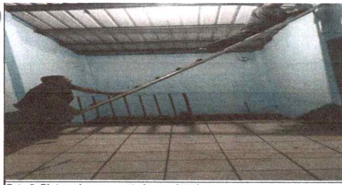
Foto 5: Pintura de muros exteriores e interiores
