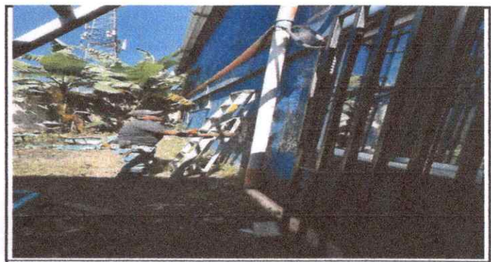
Foto 6: Reparación de bajada de agua pluvial, tubo PVC 3"
