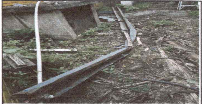
Foto 2: Sustitución de canal de metal.
