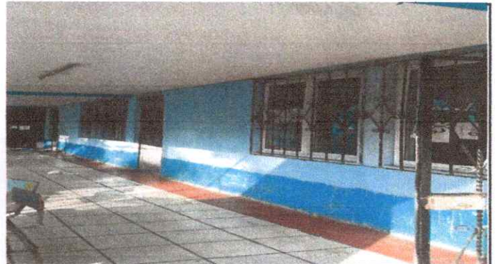
Foto 4: Pintura de muros exteriores e interiores
