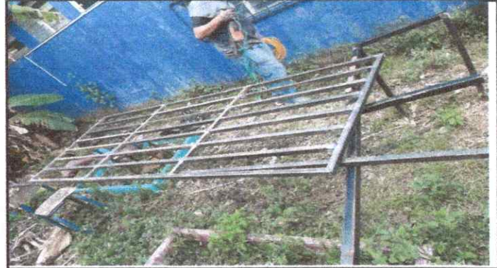
Foto 2: Fabricación e instalación de puerta de rejas
