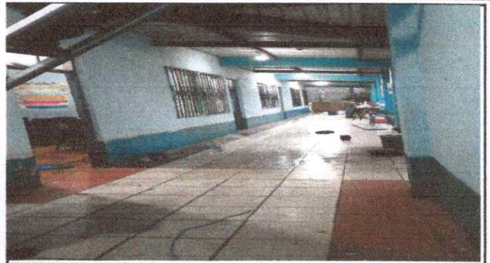
Foto 8: Pintura de muros exteriores e interiores
