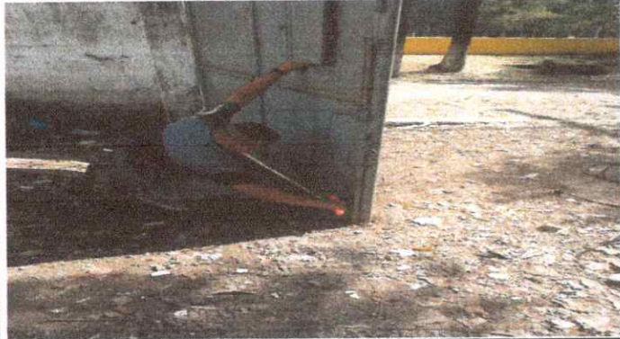
Foto 1: Mantenimiento a portones de metal
