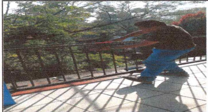
Foto 3: Mantenimiento a barandas de metal
