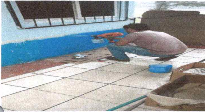
Foto 1: Pintura en muros exteriores e interiores
