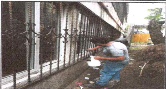
Foto 2: Mantenimiento a balcones de metal.
