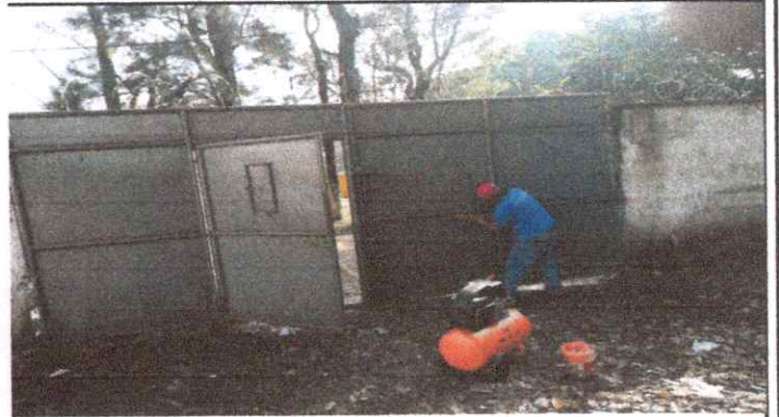
Foto 2: Mantenimiento a portones de metal
