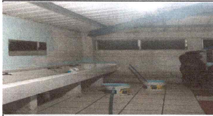
Foto 3: Pintura de muros exteriores e interiores
