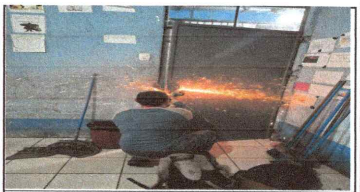
Foto 6: Sustitución de chapa
