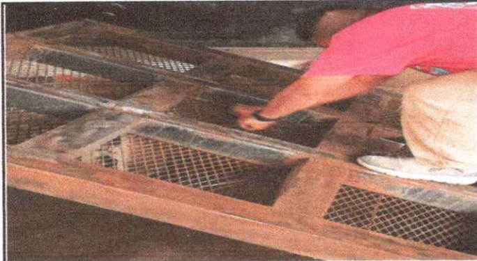
Foto 3: Instalación de estructura portante de metal
