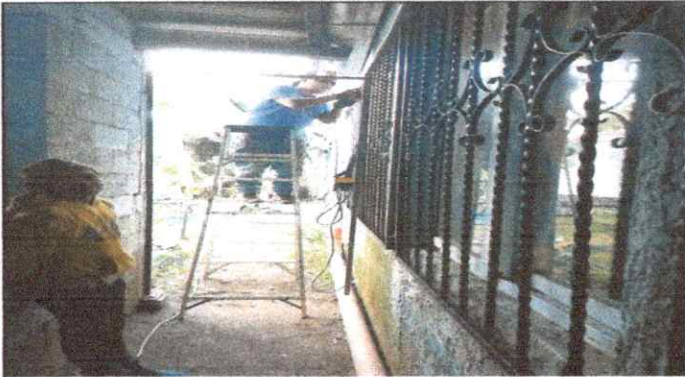
Foto 3: Fabricación e instalación de puerta de rejas
