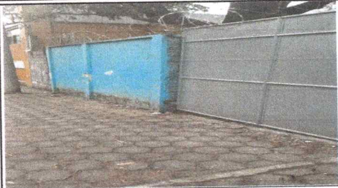
Foto 1: Reparación de cerco de alambre de pua.
