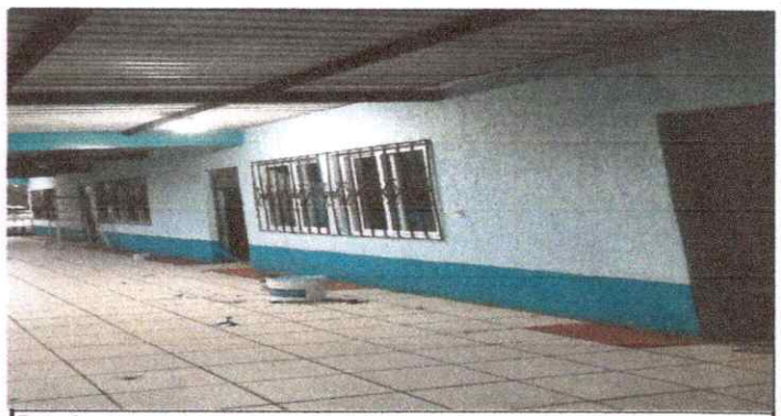
Foto 6: pintura de exteriores e interiores
