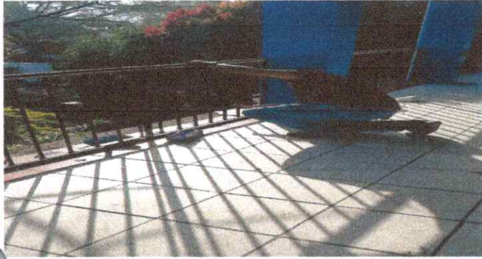
Foto 1: Mantenimiento a barandas de metal
