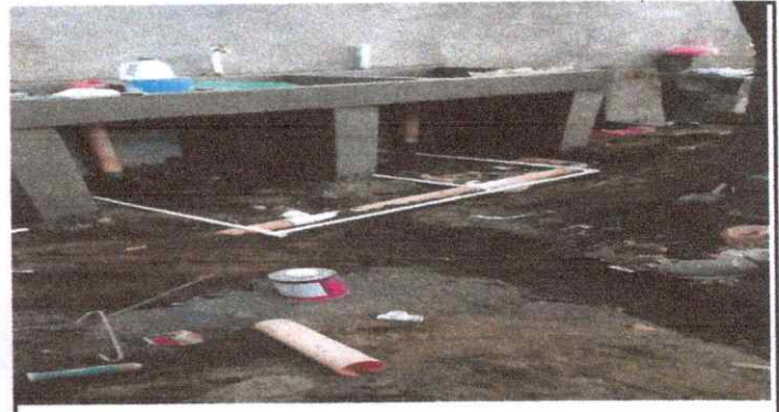
Foto 4: Instalación de tubería para agua potable
