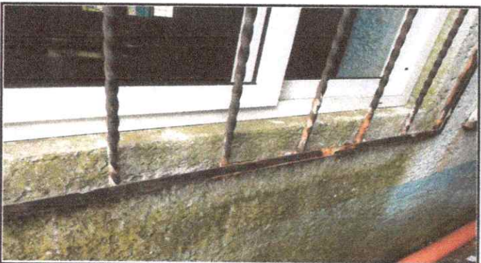
Foto 3: Mantenimiento a balcones de metal.
