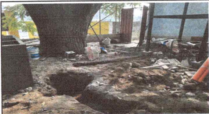
Foto 3: Instalación de tubería para agua potable
