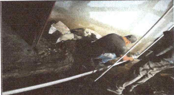
Foto 1: Instalación de tubería para agua potable
