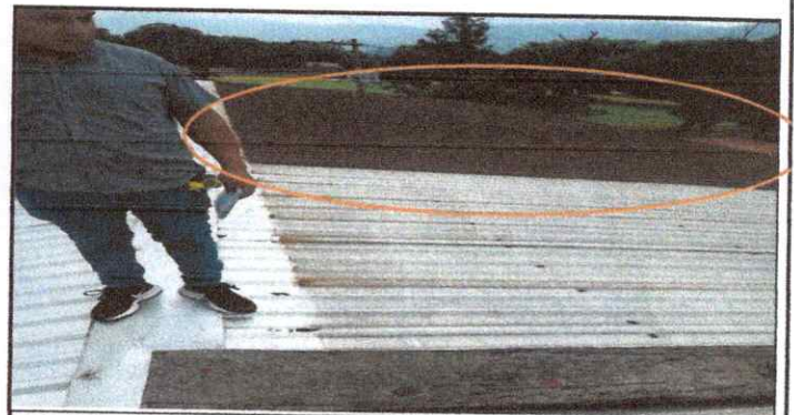
Foto 6: Sustitucion de Lamina oxidada
