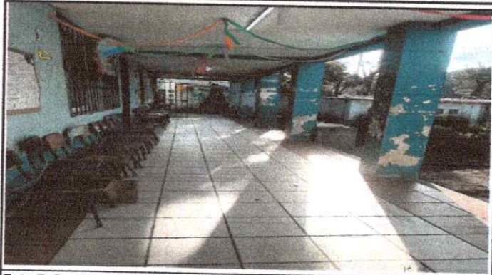
Foto 7: Sustitución de Pintura exterior de los salones y postes.
