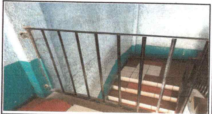
Foto 4: Mantenimiento de baranda oxidada y reparación de anclaje
