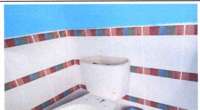
Foto 3: Cambio de acerorios en baños
