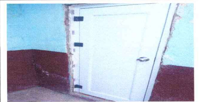
Foto 5: Instalación de Puerta en baño de maestros
