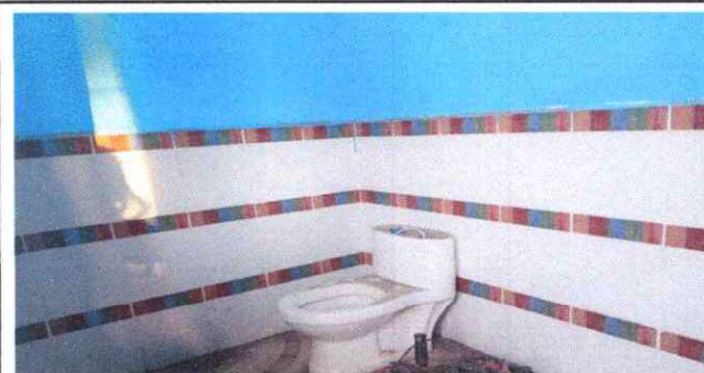
Foto 4: instalación de azulejo y piso en baños
