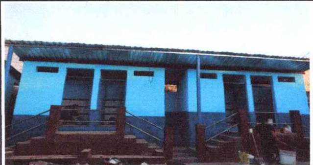
Foto 4: Techado de lamina en baños
