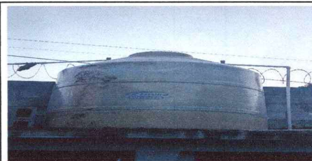
Foto 6: Instalación de Deposito de agua
