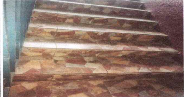
Foto 2: Instalación de piso en gradas del segundo Nivel
