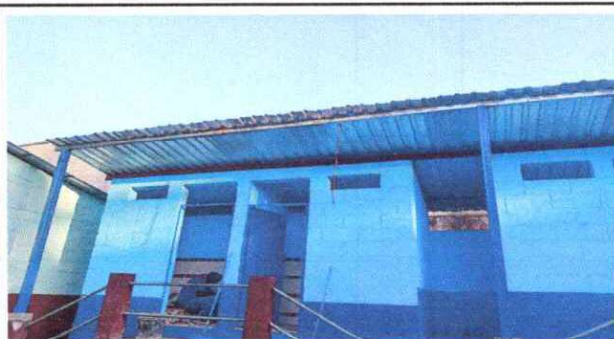
Foto 2: Techado y pintado en baños
