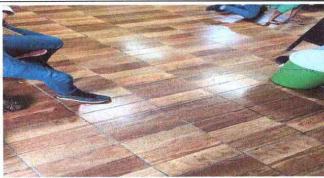
Foto 3: Instalación de piso en aulas
