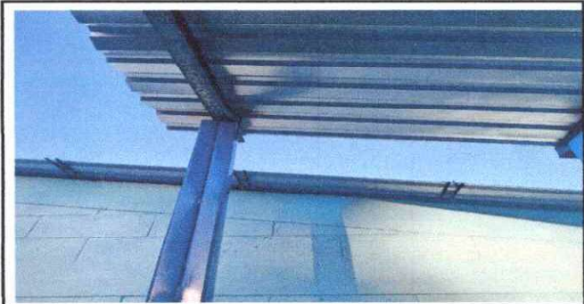
Foto 6: Instalación de techo
