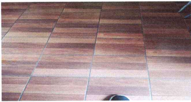
Foto 1: Instalación de piso en aulas
