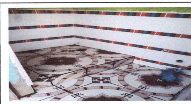
Foto 5: Durante el cambio de piso en los baños
