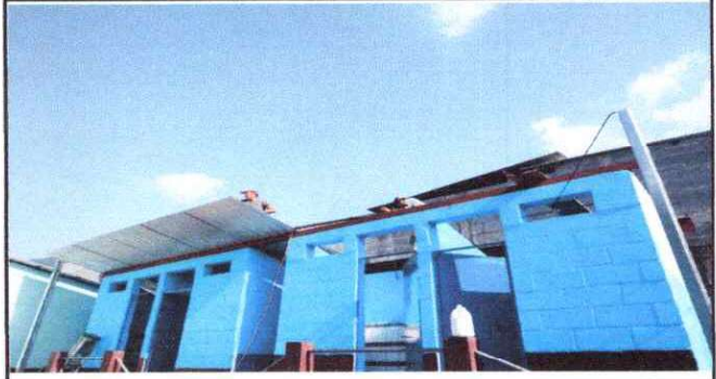
Foto 2: Durante la colocación de Laminas en techo de los baños
