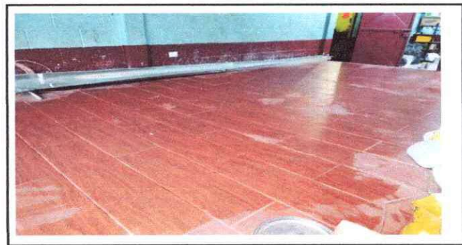
Foto 6: Durante Puesta de piso ceramico en esenario
