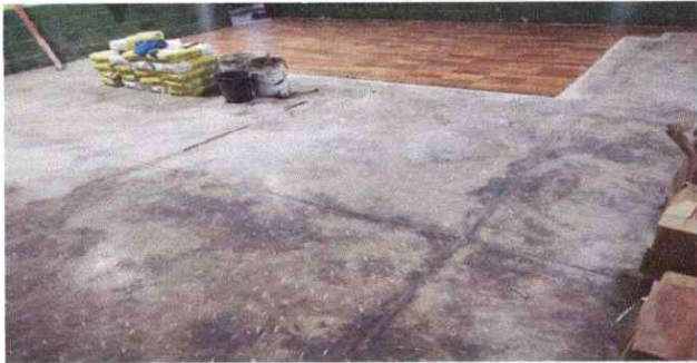
Foto 1: Durante la puesta del piso ceramico en las aulas
