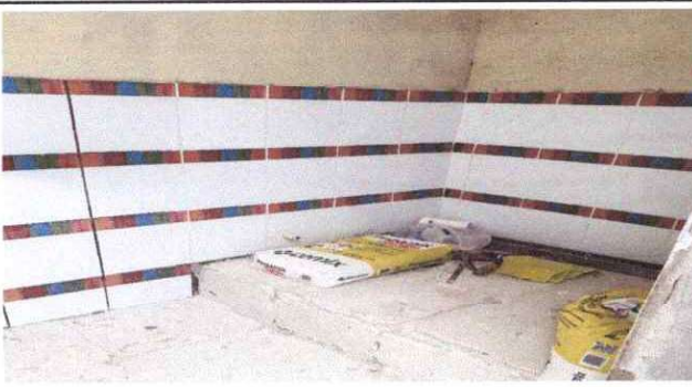
Foto 3: Durante la puesta de azulejo en los baños
