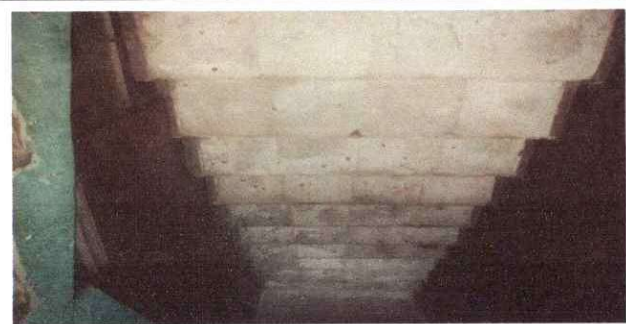
Foto 5: Durante la puesta de piso en las gradas del segundo nivel
