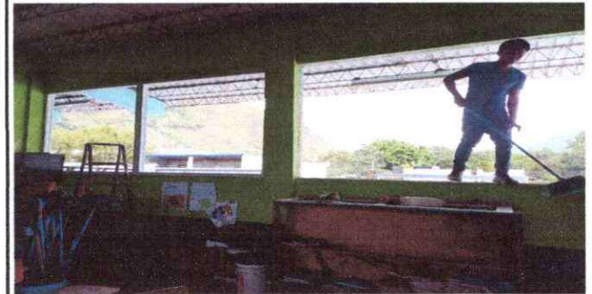
Foto 6: Durante la colocación de las ventanas de PVC
