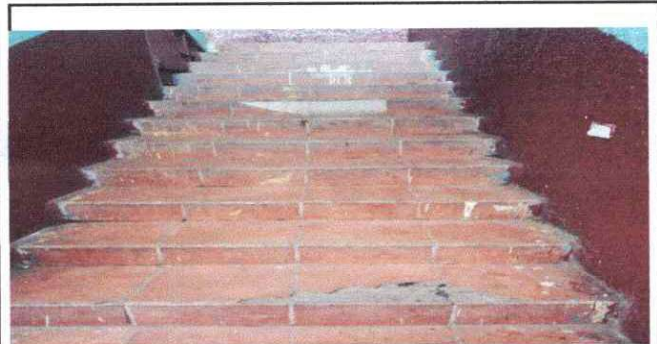
Foto 3: Cambio de piso en gradas, de segundo nivel.
