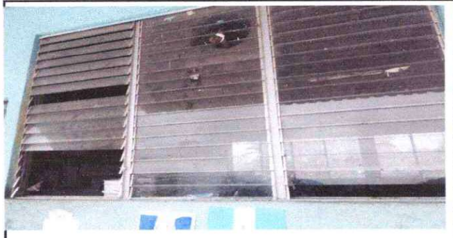
Foto 4: Cambio de Ventanas de metal por pvc
