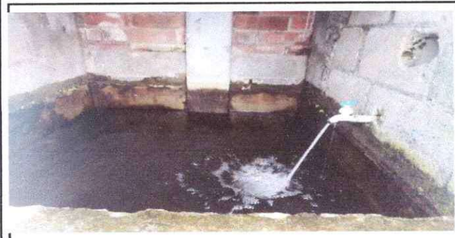
Foto 5: Mantenimiento deposito de agua
