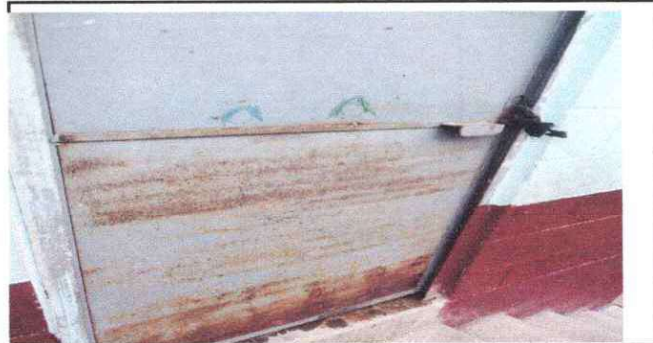
Foto 6: Mantenimiento de pintura a 4 baños
