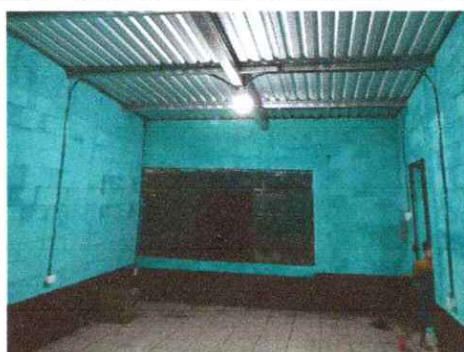
Foto 4: Terminado el proceso de remozamiento. Salón 4
