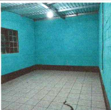
Foto 3: Terminado el proceso de remozamiento. Salón 3
