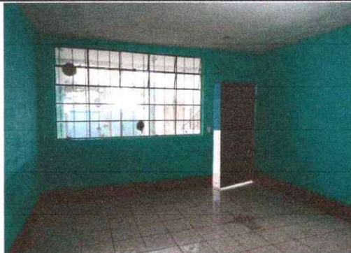
Foto 2: Terminado el proceso de remozamiento. Salón 2
