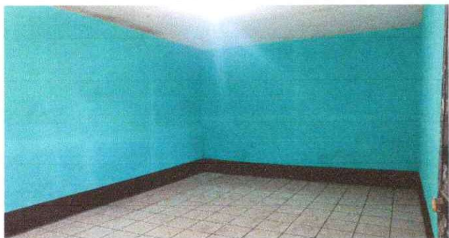
Foto 1: Terminado el proceso de remozamiento. Salón 1
