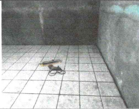
Foto 3: Sustitución de piso. Salón 1
