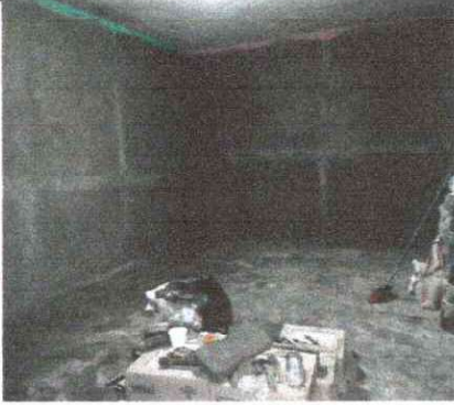
Foto 1: Repello se pared. Salón 1
