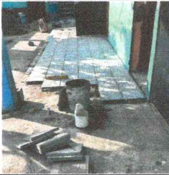
Foto 5: Sustitución de piso del corredor
