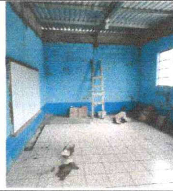
Foto 4: Sustitución de piso. Salón 3.
