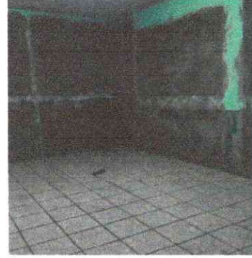
Foto 2: Sustitución de piso. Salón 2
