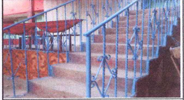
Foto 16: Mantenimiento a barandas de metal.
