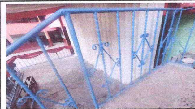
Foto 15: Mantenimiento a barandas de metal.
