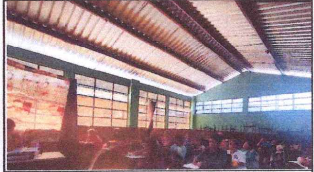
Foto 14: Sustitución de lámina por lámina troquelada aluzinc.
