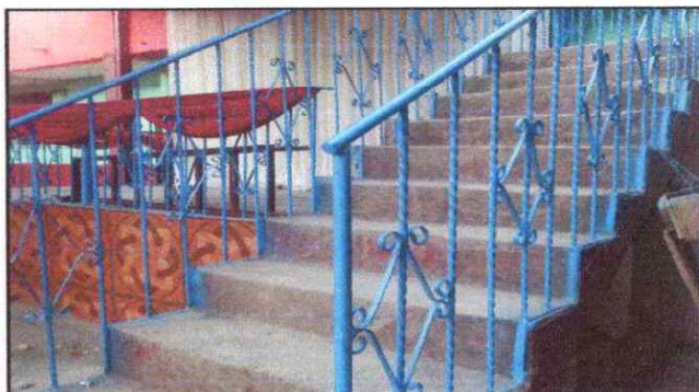
Foto 16: Mantenimiento a barandas de metal.
