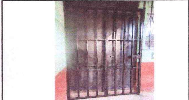
Foto 8: Mantenimiento a estructura de metal reja.
