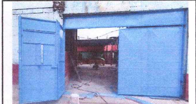
Foto 10: Mantenimiento a portón de metal.
