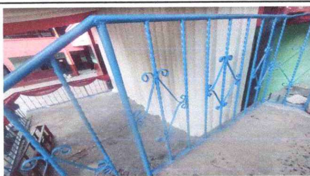
Foto 15: Mantenimiento a barandas de metal.
