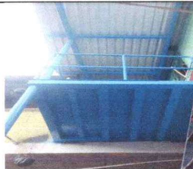
Foto 18: Mantenimiento a estructura portante de metal.
