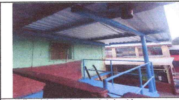
Foto 17: Mantenimiento a estructura portante de metal.
