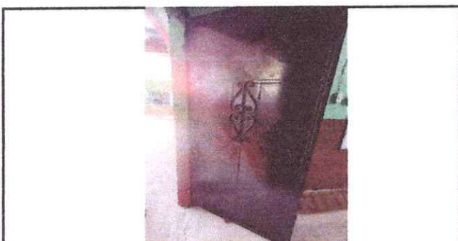
Foto 11: Mantenimiento a estructura de metal puerta y cambio de chapas
