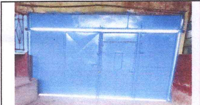
Foto 9: Mantenimiento a portón de metal.
