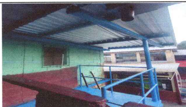
Foto 17: Mantenimiento a estructura portante de metal.
