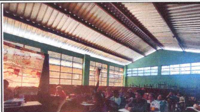
Foto 14: Sustitución de lámina por lámina troquelada aluzinc.
