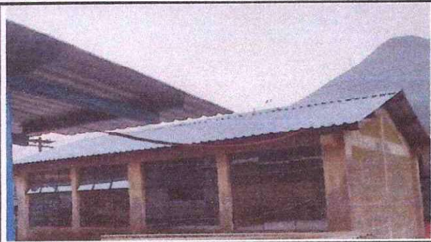
Foto13: Sustitución de lamina por lámina troquelada aluzinc.
