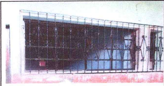
Foto 7: Mantenimiento a estructura de metal ventana y fabricación de ventana
