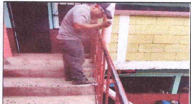
Foto 22: Mantenimiento a barandas de metal.
