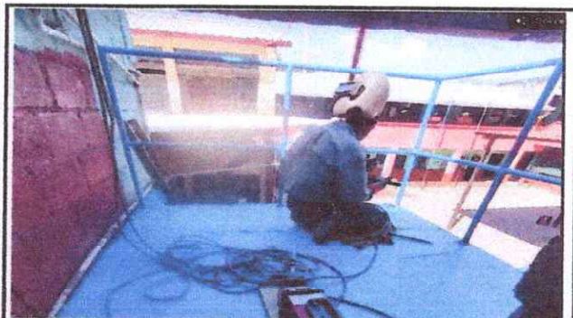
Foto 28: Mantenimiento a estructura portante de metal.
