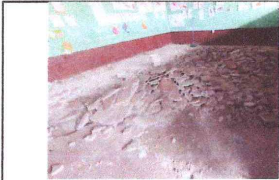
Foto1: Sustrucción de piso cerámico.
