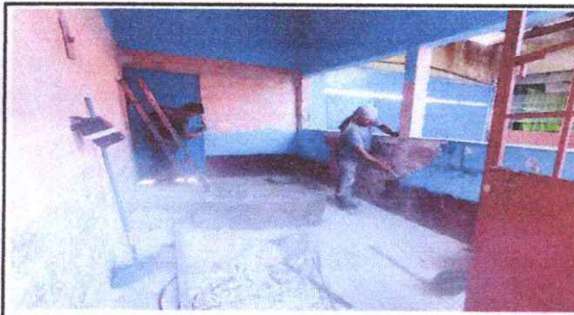
Foto 9: Sustitución de piso cerámico y azulejo.
