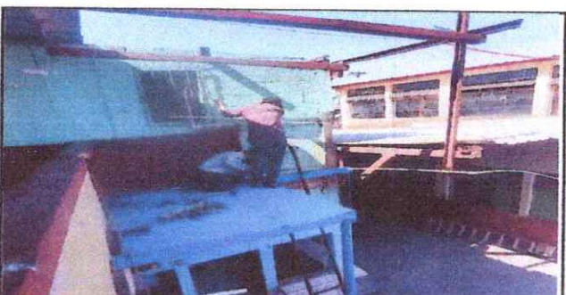
Foto 30: Mantenimiento a estructura portante de metal.)
