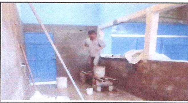
Foto 11: Sustitución de piso cerámico y azulejo.
