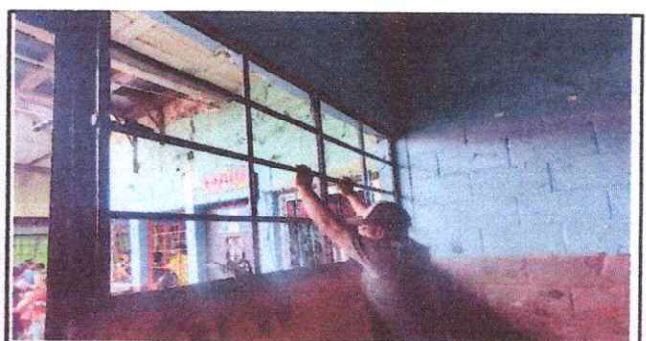
Foto 24: Mantenimiento y fabricación de estructura de metal ventanas.
