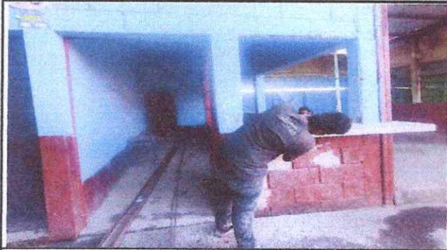
Foto 7: Sustitución de piso cerámico y azulejo.
