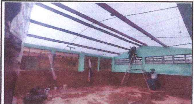
Foto 20: Sustitución de lámina por lámina troquelada aluzinc.
