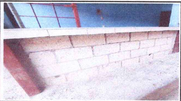
Foto 8: Sustitución de piso cerámico y azulejo.
