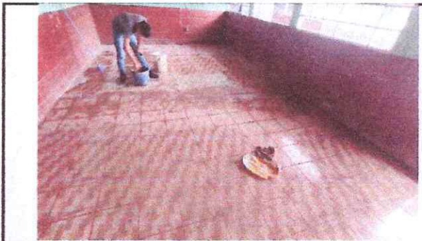
Foto 6: Sustrucción de piso cerámico
