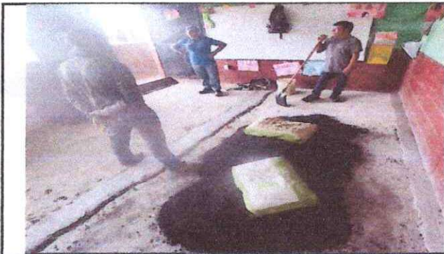
Foto 3: Sustrucción de piso cerámico.
