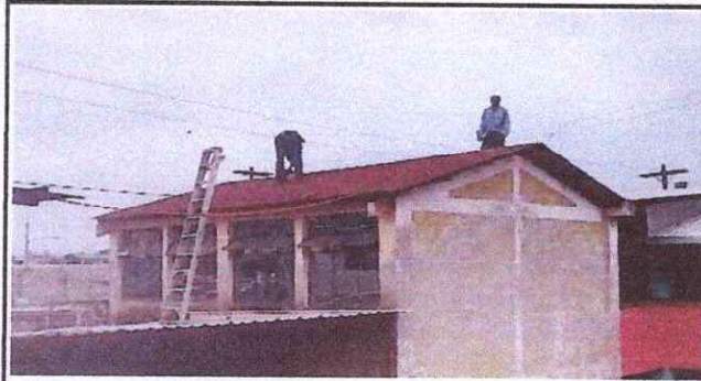
Foto 25: Sustrucción de lámina por lámina troquelada aluzinc.
