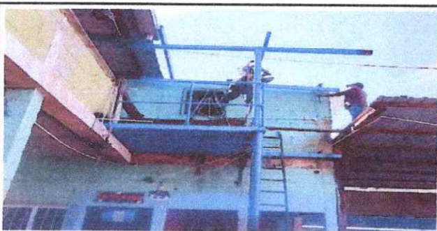
Foto 29: Mantenimiento a estructura portante de metal.
