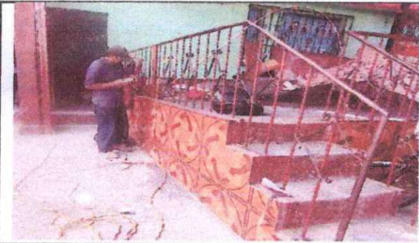
Foto 21: Mantenimiento a barandas de metal.
