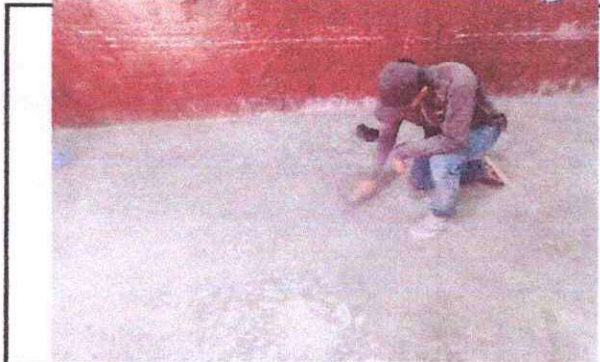
Foto 4: Sustrucción de piso cerámico.
