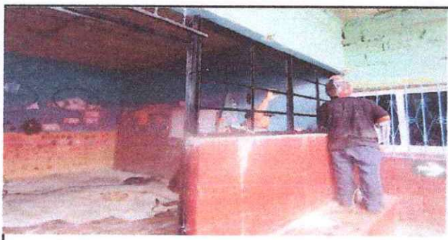
Foto 23: Mantenimiento y fabricación de estructura de metal ventana.
