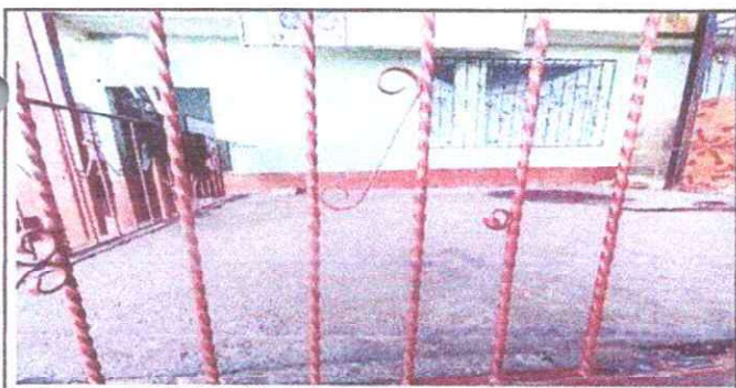
Foto 23: Mantenimiento a barandas de metal.
