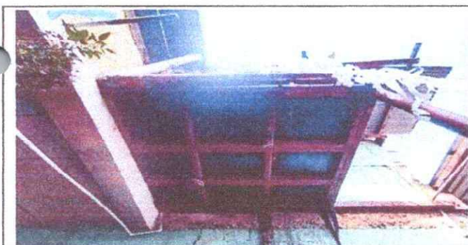
Foto 11: Reparación de plataforma de cisterna de agua.
