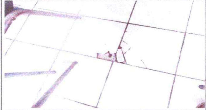
Foto 13: Sustitución de piso cerámico en salones.
