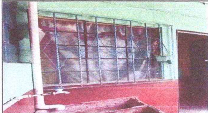
Foto 10: Mantenimiento a estructura de metal de ventana.
