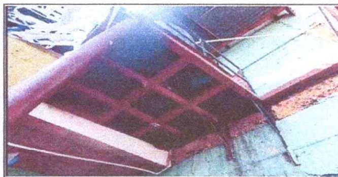
Foto 12: Reparación de plataforma de cisterna de agua
