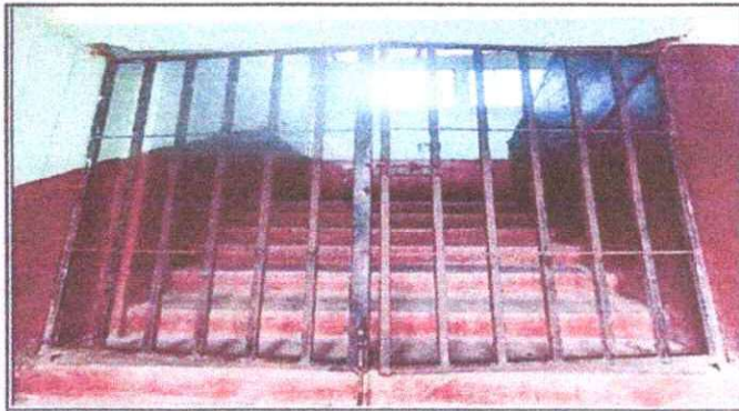
Foto 8: Mantenimiento a barandas de metal.
