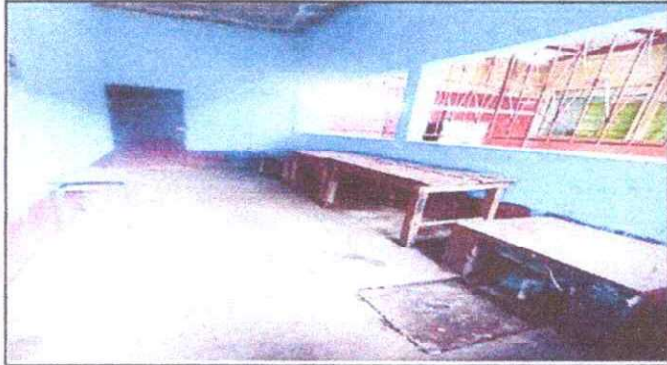
Foto 19: Sustitución de piso cerámico.
