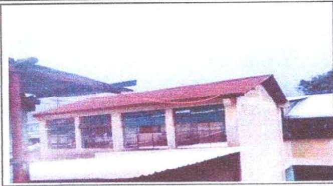
Foto 1: Sustitución de lámina, por por lámina troquelada aluzinc calibre 26.
