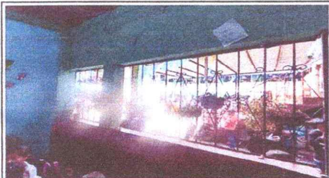
Foto 9: Mantenimiento a estructura de metal de ventana.
