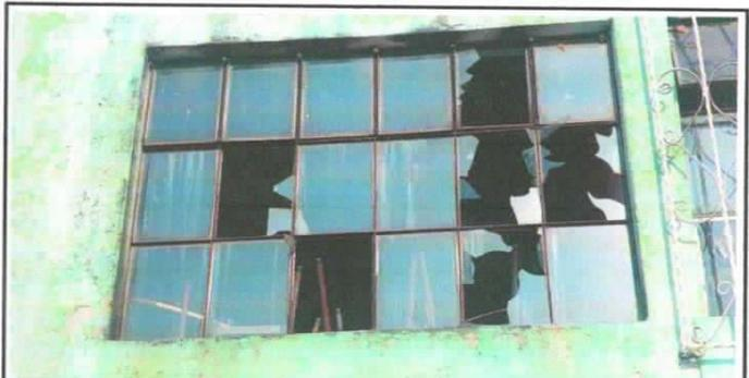
Foto 10: vidrios rotos y estructura metálica dañada por óxido y paso del tiempo
