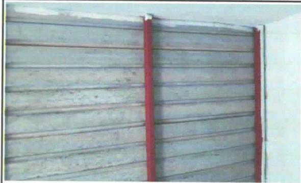
Foto 2: Techo dañado por el paso del tiempo, lámina picada por lluvias y arena volcánica
