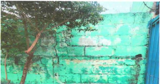
Foto 5: daños estructurales en muro por mala construcción y posición del terreno
