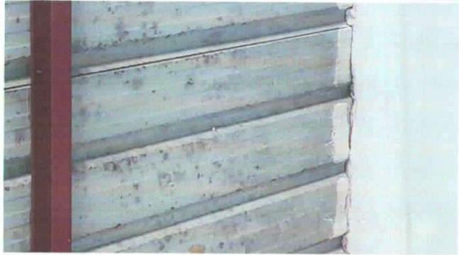
Foto 1: Techo dañado por el paso del tiempo, con endiduras y goteras
