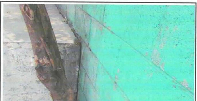
Foto 4: desprendimiento de pared contigua al escenario por mala construcción y posición del terreno
