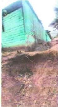
Foto 7: erosión por corrimiento de agua a un costado de muro perimetral que hace necesario la reparación de la cuneta
