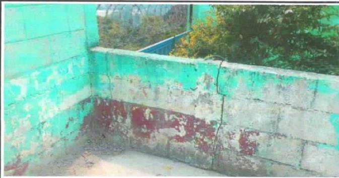
Foto 3: Daños estructurales en muro por mala construcción y posición del terreno
