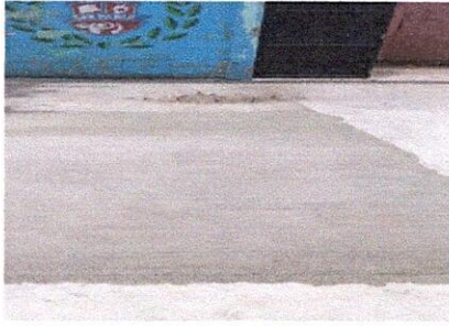
Foto 1: 16.1. Reparación de planchas de concreto losa de patio.
