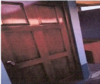
Foto 5: 4.3. Sustitución de puertas. Puertas y tableros de madera.
