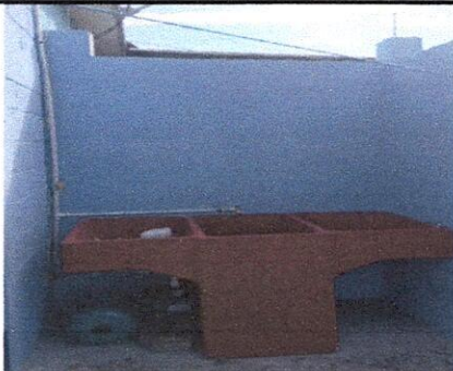
Foto 3: 20.10. Sustitución de pila de cemento de dos lavaderos.
