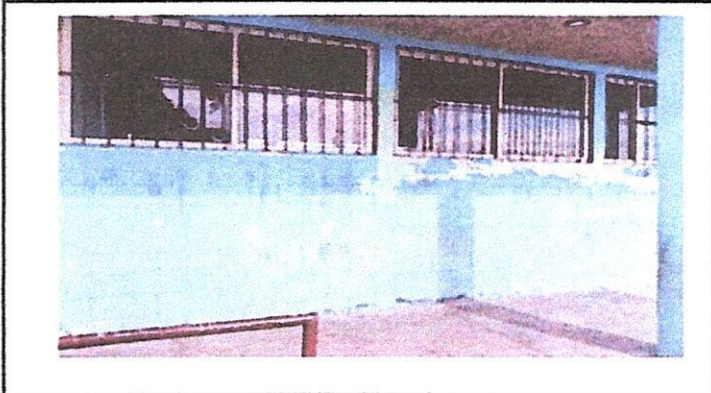
Foto 4: 9.1. PINTURA EN MURO INTERIOR
