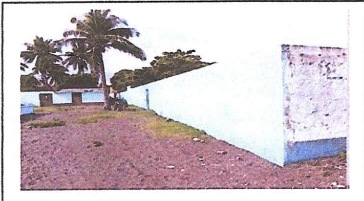
Foto 3: 9. 9.1. PINTURA EN MUROS EXTERIOR
