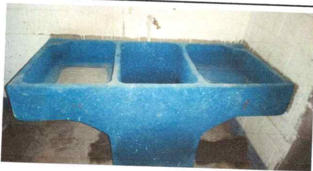
Foto 11: Region 19.20 Instalación de pila
