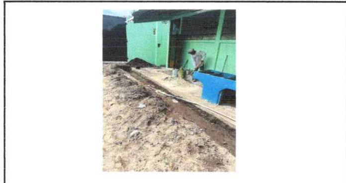
Foto 10: Region 19.21 (Instalacion de tuberia de agua potable).
