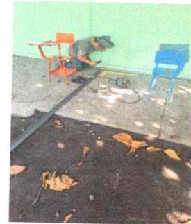
Foto 4: Puerta de madera en baño en mal estado, Reglon 4.2 (Sustitucion de puertas).
