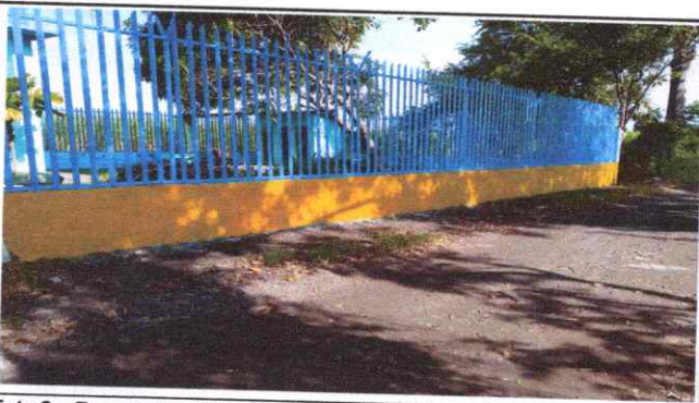
Foto 8: Reparación del muro. 15.2
