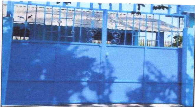
Foto 4: Mantenimiento del portón 4.5
