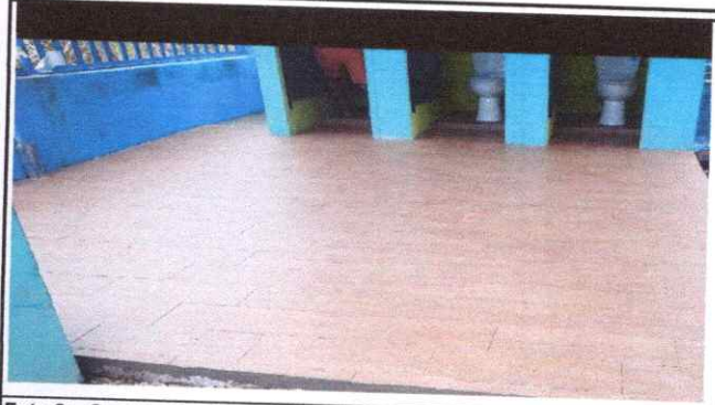
Foto 8: Sustitución de inodoros Renglón 10.3
