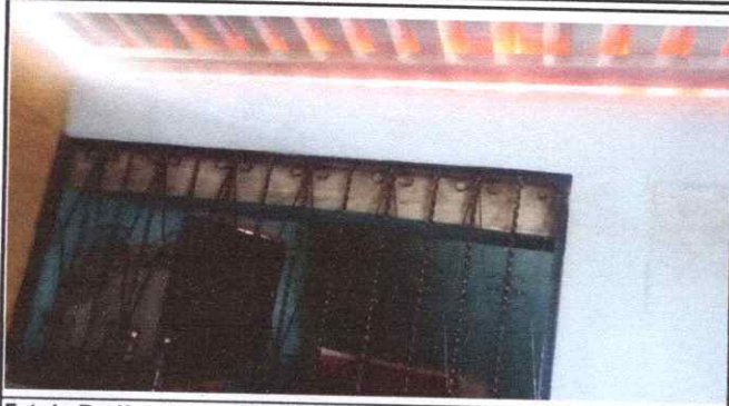
Foto 1: Reglón. 1.1. 19.8 Y 19.9 Cambio de lámina Z
