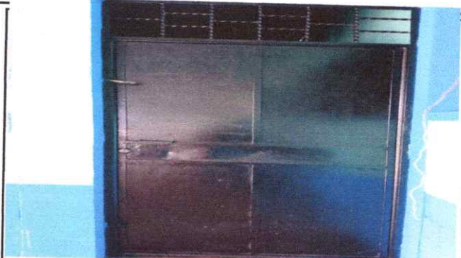
Foto 2: Mantenimiento de puertas 4.1
