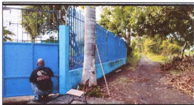
Foto 4: Mantenimiento del portón 4.5
