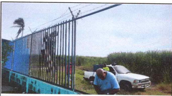
Foto 8: Reparación del muro. 15.2
