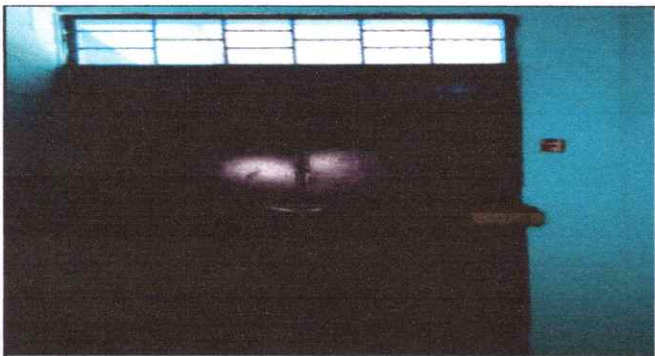
Foto 3: Cambio de chapa 4.2
