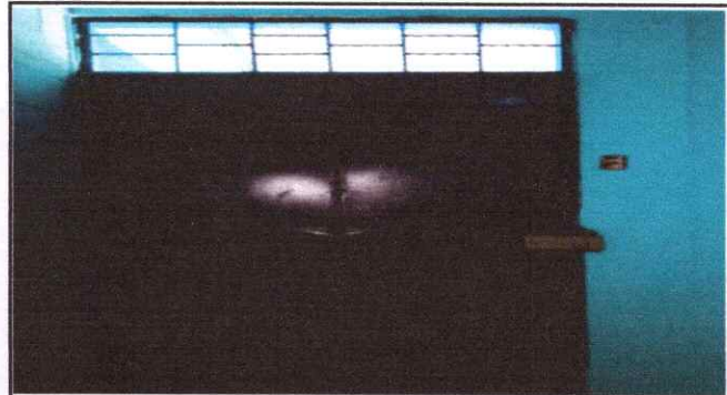
Foto 2: Mantenimiento de puertas 4.1
